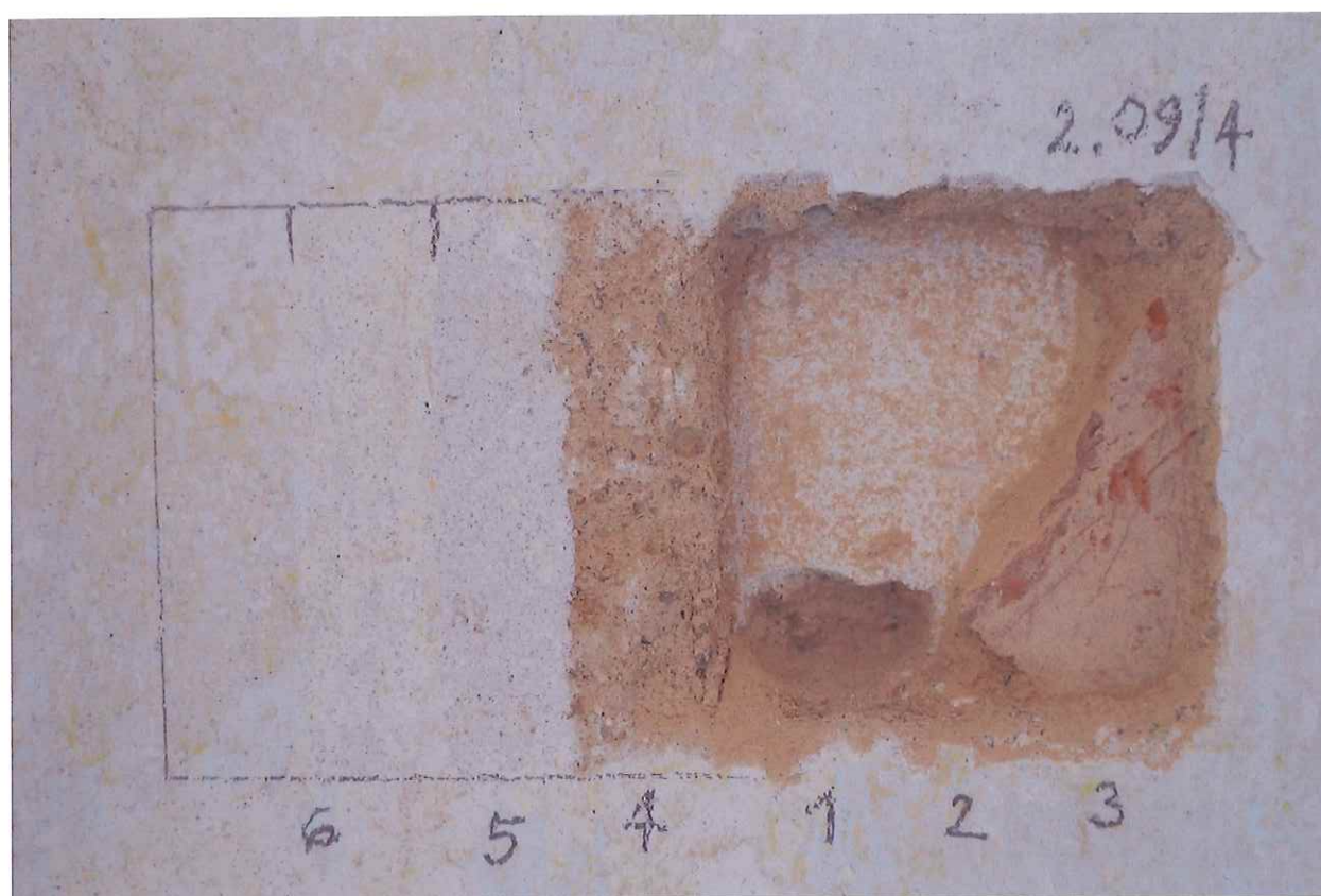
Sonda 2.09/4 na stěně – 1-2 cihlové zdivo a jednovrstvá váp. omítka s váp. nátěrem, 3 plentování pomocí střešních tašek, 4- 6 souvrství váp. omítky a hlínkových nátěrů
