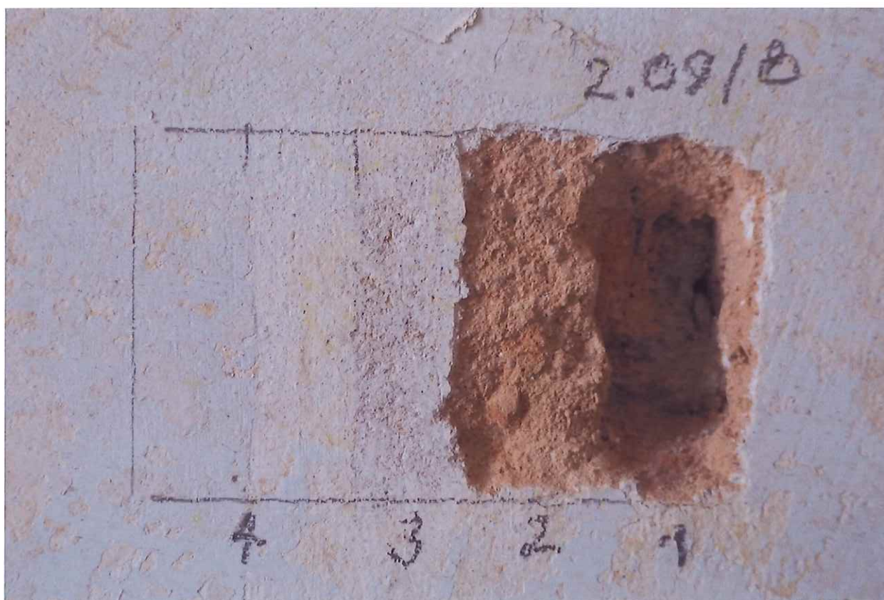
Sonda 2.09/9 na stěně – 1-2 cihlové zdivo a jednovrstvá váp. omítka, 3 vrstva váp. štuky, 4 souvrství hlínkových nátěrů
