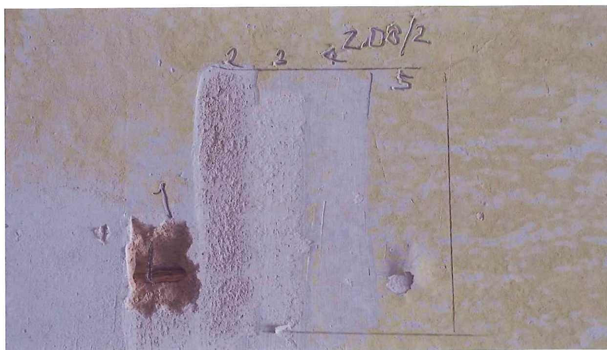
Sonda 2.08/2 na stropu – 1 rákosové pletivo, 2 váp. omítka žlutého zabarvení, 3 štuková vrstva, 4-5 monochromní hlinková vrstva
