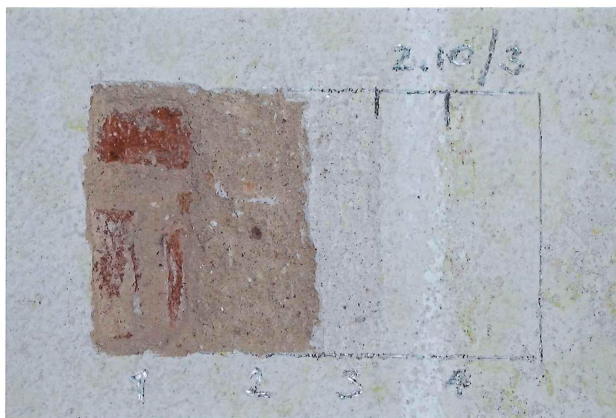
Sonda 2.10/3 na SV stěně – 1 cihlové zdivo, 2 jednovrstvá váp. omítka, 3 štuková vrstva, 4 souvrství malířských nátěrů
