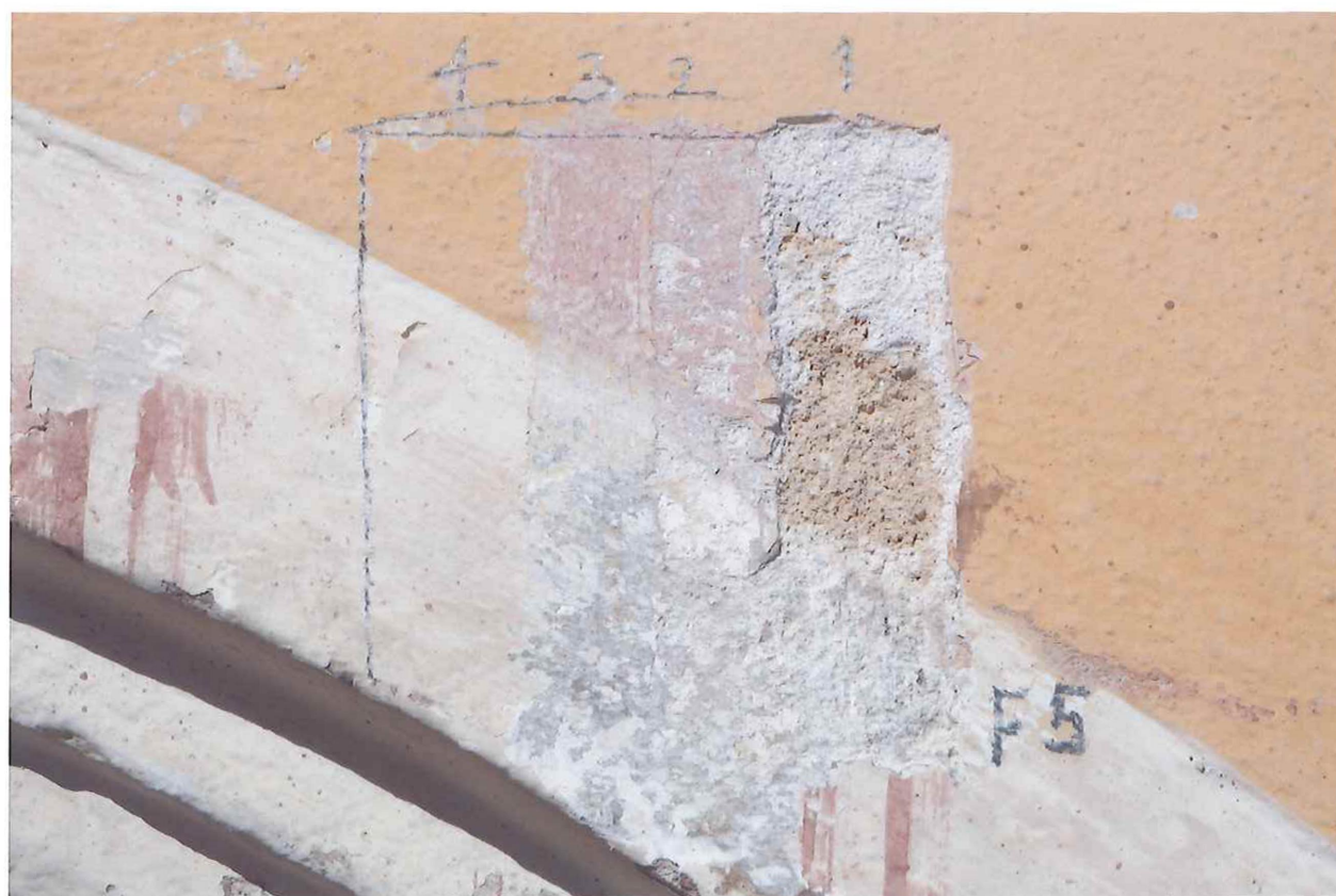
Sonda F5 na okenním lemu segmentového okna vlevo v přízemí – 1 váp. omítka a štuková vrstva, 2-4 barevné vrstvy
