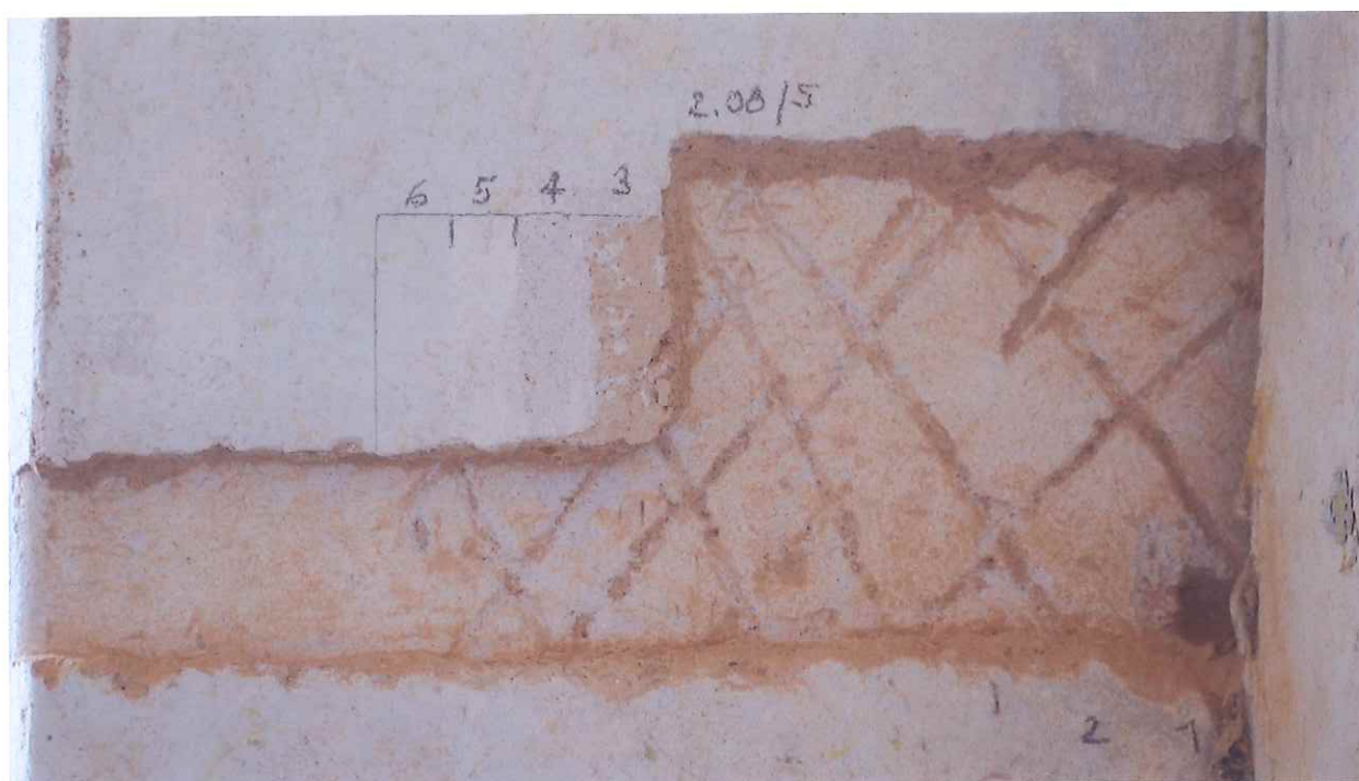
Sonda 2.07/6 na stěně – 1 cihlové zdivo, 2 jednovrstvá váp. omítka s vápeným nátěrem a rytou strukturou pro lepší soudržnost mladší omítky, 3-4 váp. omítka s vrstvou váp. štuky, 5-6 monochromní hlínková výmalba doplněná válečkovým dekorem
