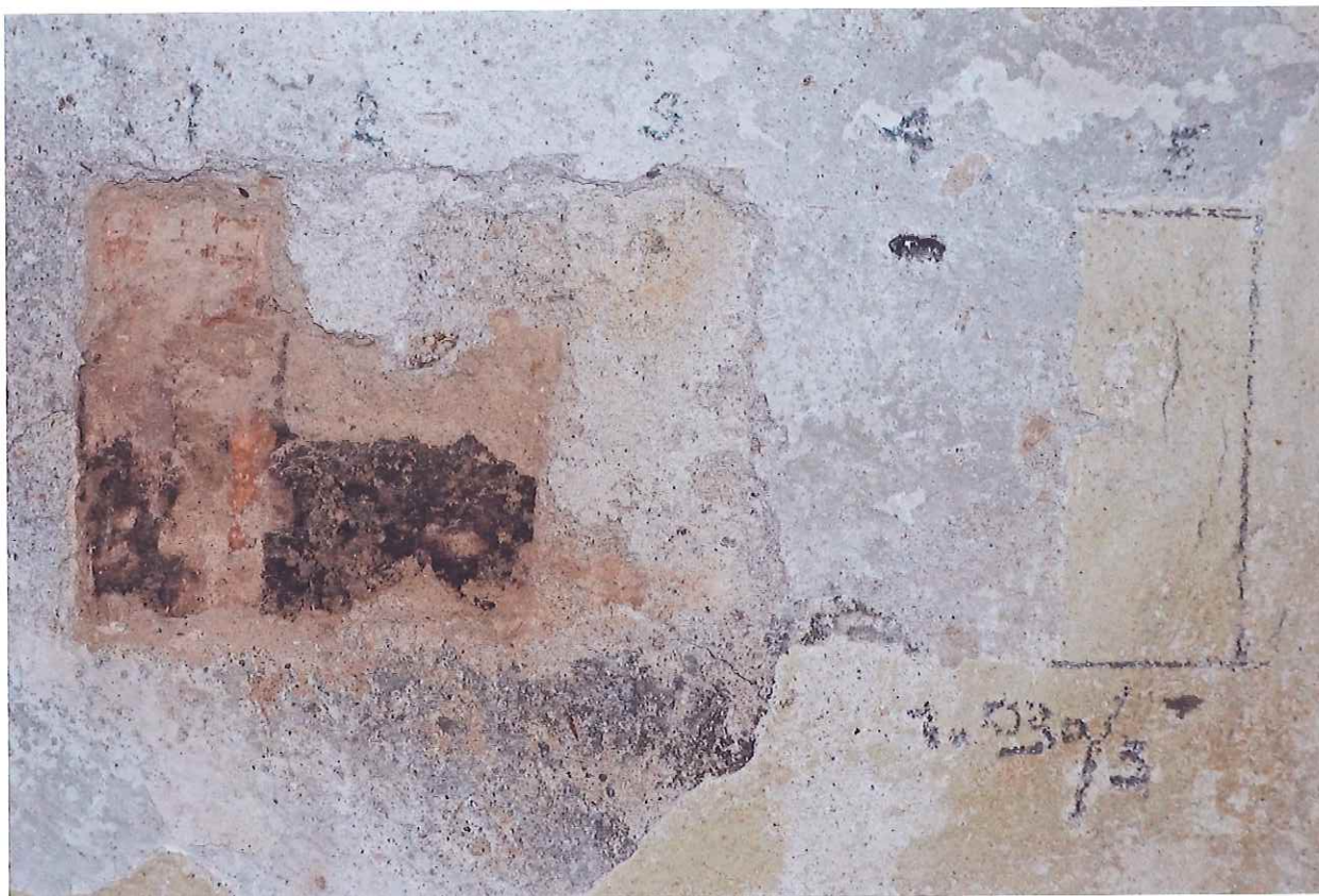
Sonda 1.03a/3 na stěně – 1 cihlové zdivo, 2 jednovrstvá váp. omítka, 3 štuková vrstva, 4-5 souvrství monochromních nátěrů
