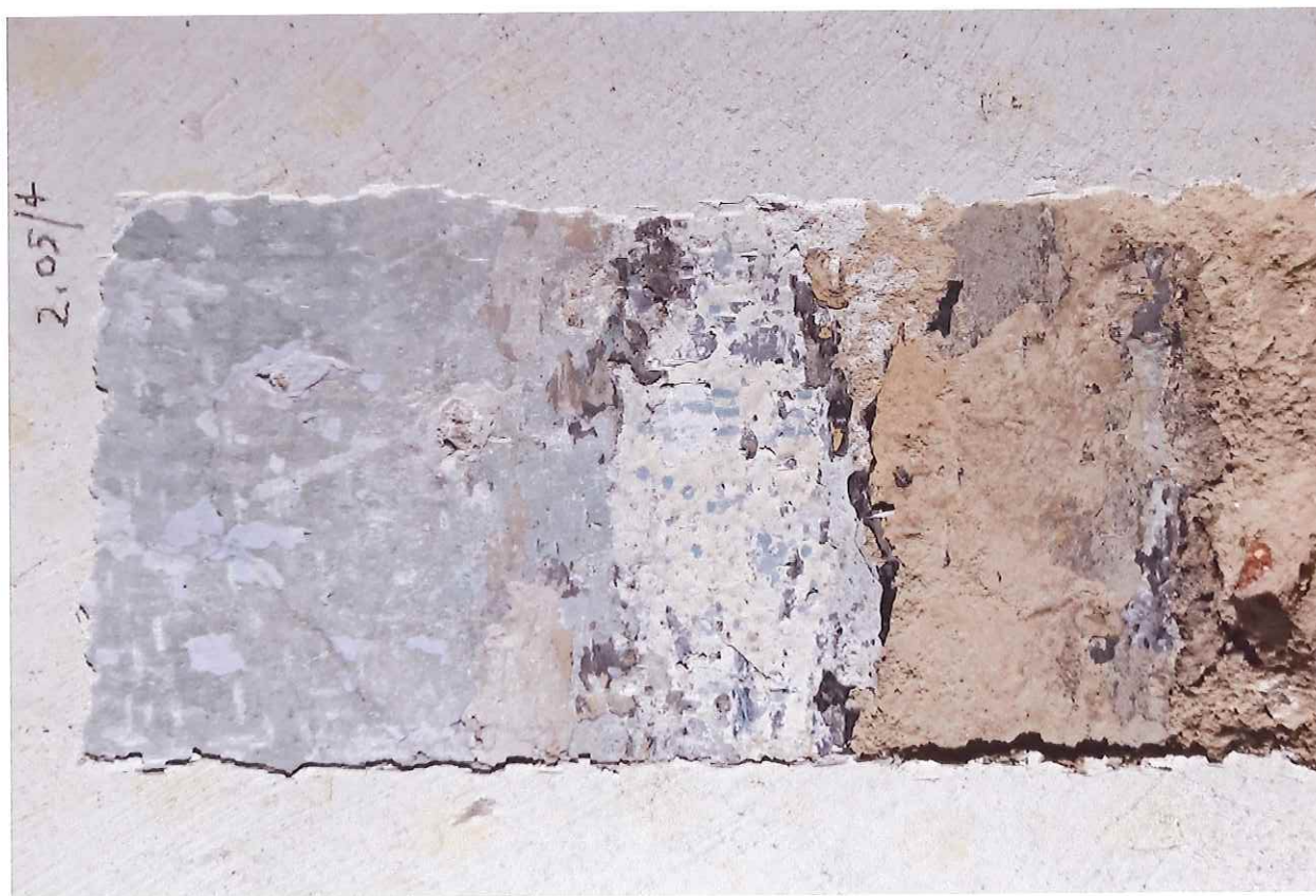
Sonda 2.05/4 na stěně (příčka) – ukázka bohatého vrstvení vápenné a hlínkové výmalby
