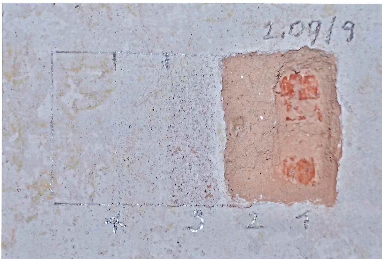
Sonda 2.09/9 na stěně – 1-2 cihlové zdivo a jednovrstvá váp. omítka, 3 vrstva váp. štuku, 4 souvrství hlínkových nátěrů
