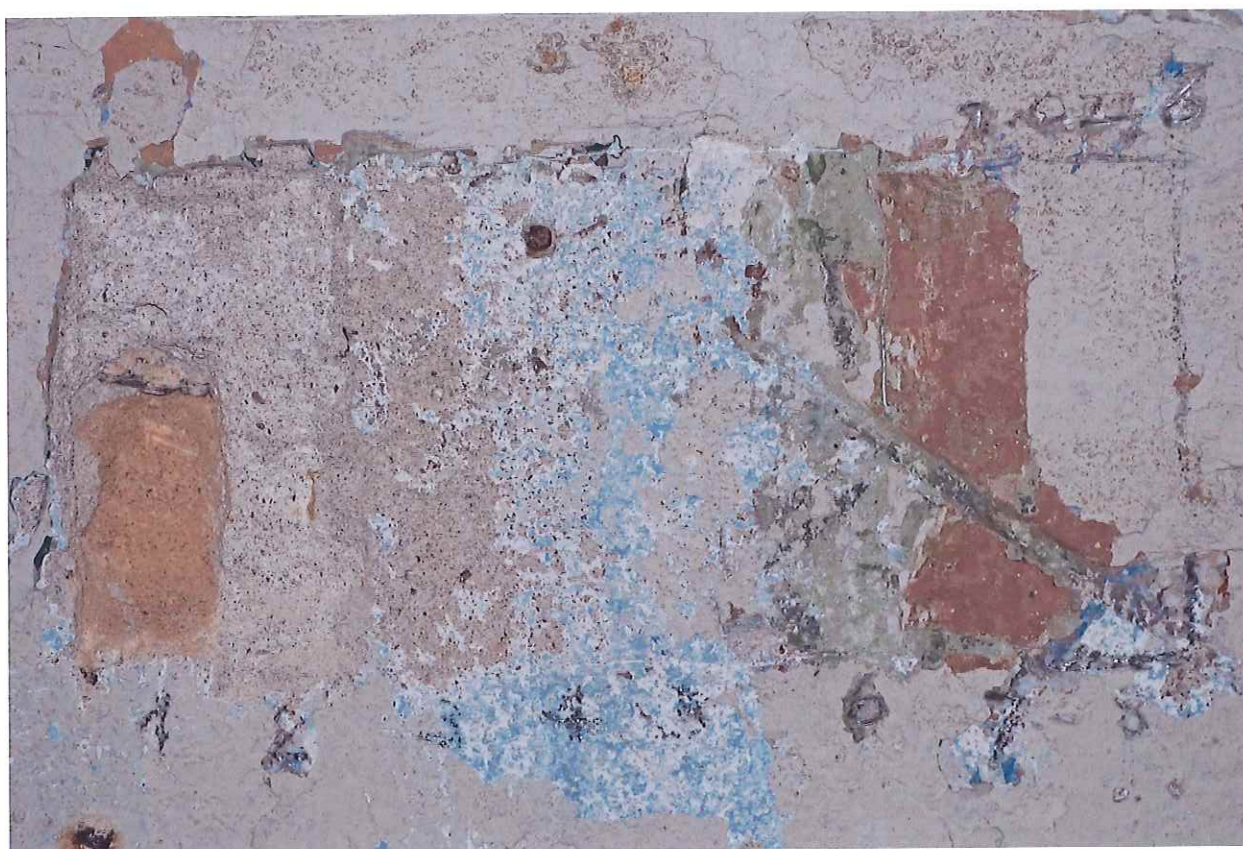
Sonda 1.02/5 na SV stěně – 1 kamenné zdivo, 2 jednovrstvá váp. omítka, 4 monochromní váp. nátěr, 5-7 souvrství váp. nátěrů s vál. dekorem (vrstva 6), 8 štuková vrstva a monochromní hlínkový nátěr
