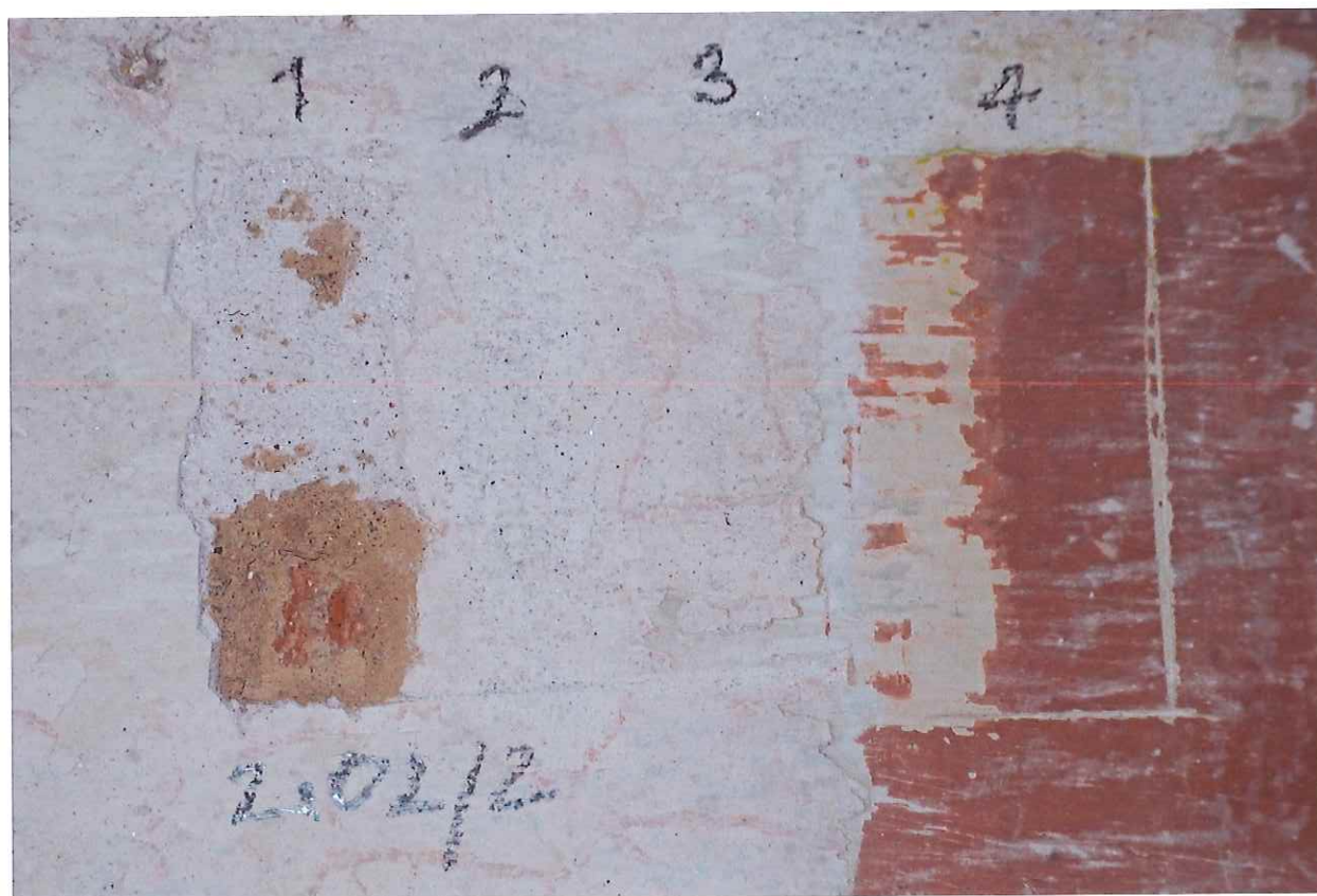
Sonda 2.02/2 na stěně – 1-2 cihlové zdivo a jednovrstvá váp. omítka, 3 vrstva váp šuku, 4 monochromní hlínková výmalba
