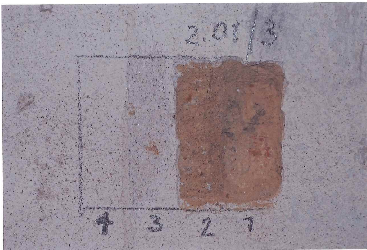
Sonda 2.01/3 na stěně – 1 cihlové zdivo, 2 jednovrstvá váp. omítka, 3 štuková vrstva, 4 souvrství monochromních nátěrů
