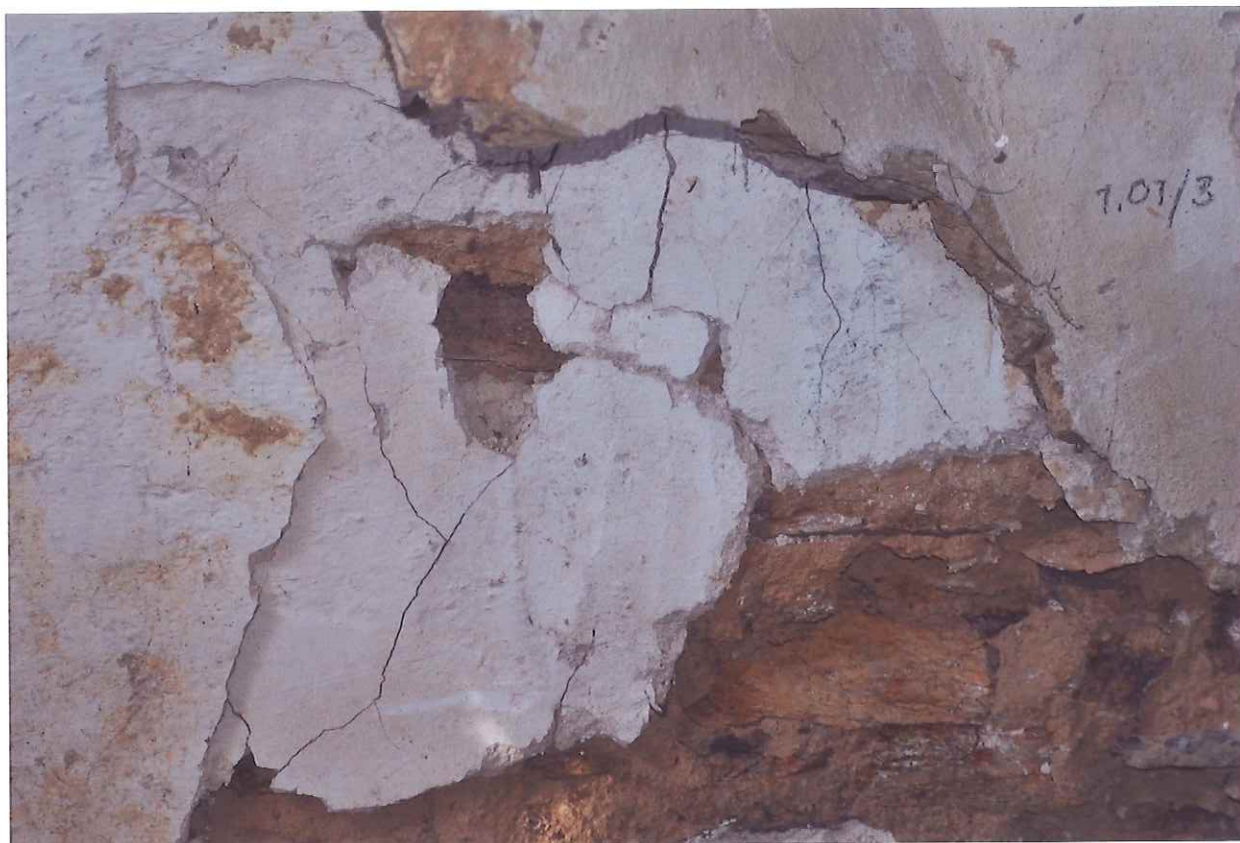
Sonda 1.01/3 – ukázka nejstarší omítkové vrstvy vlevo od vstupní brány, která je pod mladší zazdívkou
