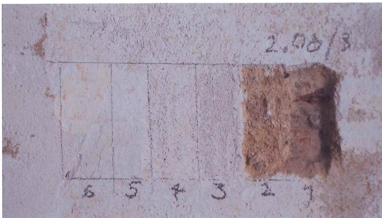
Sonda 2.08/3 na stěně – 1 cihlové zdivo, 2 jednovrstvá váp. omítka, 3 vrstva váp štuky, 4-6 monochromní hlínková výmalba doplněná válečkovým dekorem
