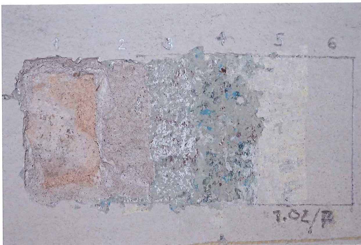
Sonda 1.02/7 na SV stěně – 1 kamenné zdivo, 2 jednovrstvá váp. omítka, 3-5 souvrství váp. a hlínkových nátěrů s válečkem (vrstva 4), 6 souvrství štuky a hlínkové monochromní výmalby
