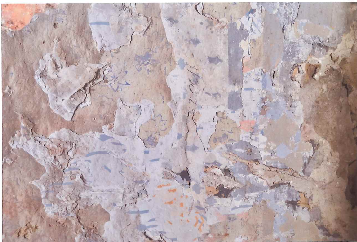
Ukázka fragmentárně dochovaného souvrství vápenných nátěrů s modrými dekory pod mladší zazdívkou
