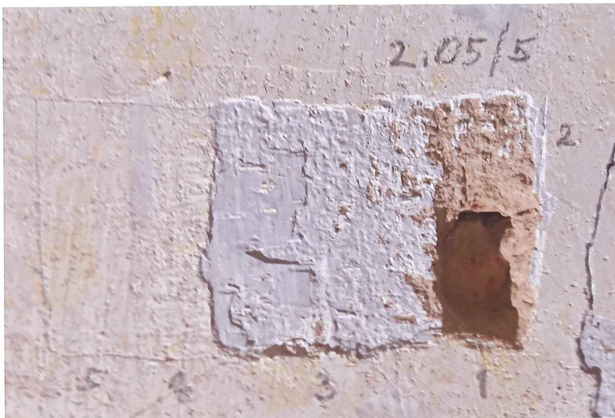
Sonda 2.05/5 na stěně – 1 cihlové zdivo, 2 jednovrstvá váp. omítka, 3 vrstva váp šuku a souvrství váp. nátěrů, 4-5 váp. šuk a souvrství monochromní hlínkové výmalby
