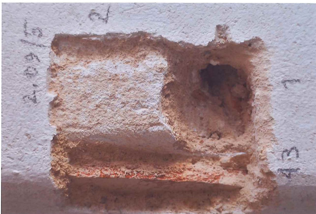
Sonda 2.09/5 na stěně a okenní špaletě – 1-2 cihlové zdivo a jednovrstvá váp. omítka s váp. nátěrem, 3 plentování pomocí střešních tašek, 4 souvrství váp. omítky a hlínkových nátěrů
