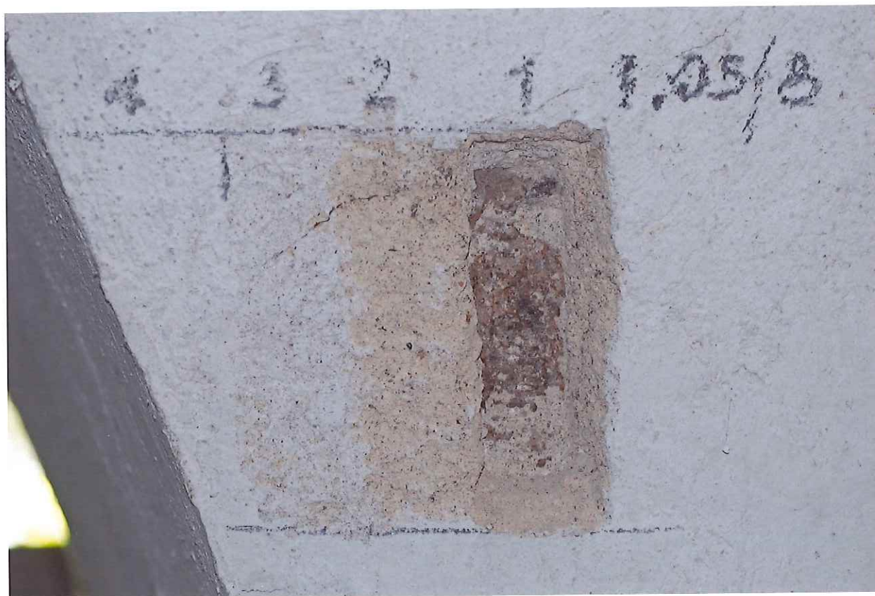
Sonda 1.05/8 na stěně – 1 kamenné zdivo, 2 jednovrstvá váp. omítka, 3 štuková vrstva, 4 souvrství monochromních nátěrů
