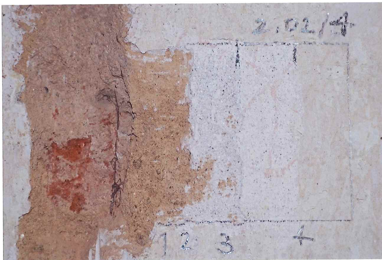
Sonda 2.07/6 na stěně – 1-2 cihlové zdivo a jednovrstvá váp. omítka, 3 vrstva váp štuku, 4 souvrství monochromní hlínková výmalba
