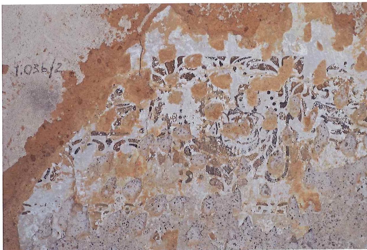
Sonda 1.03b/2 na SV stěně – ukázka šablonového dekoru s figurálním motivem na nejstarší dochované hrubozrnné váp. omítce
