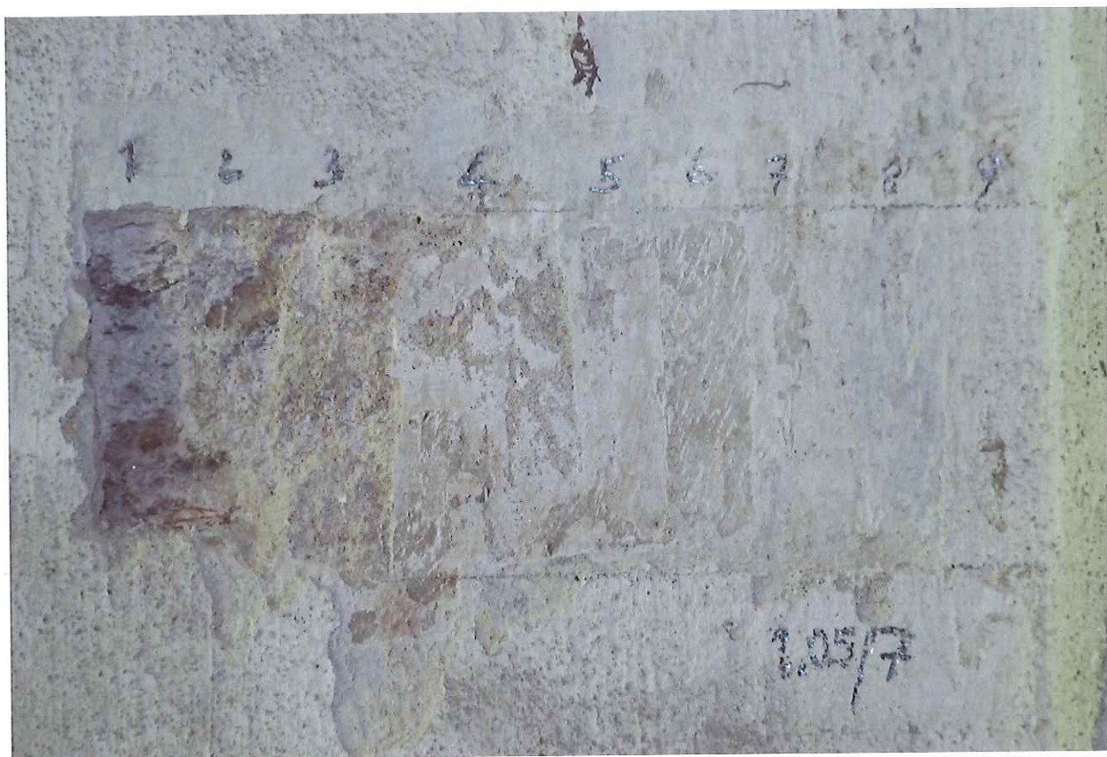
Sonda 1.05/7 na stěně – 1 kamenné zdivo, 2 jednovrstvá váp. omítka, 3 opravná omítka, 4 štuková vrstva, 5-9 souvrství monochromních nátěrů
