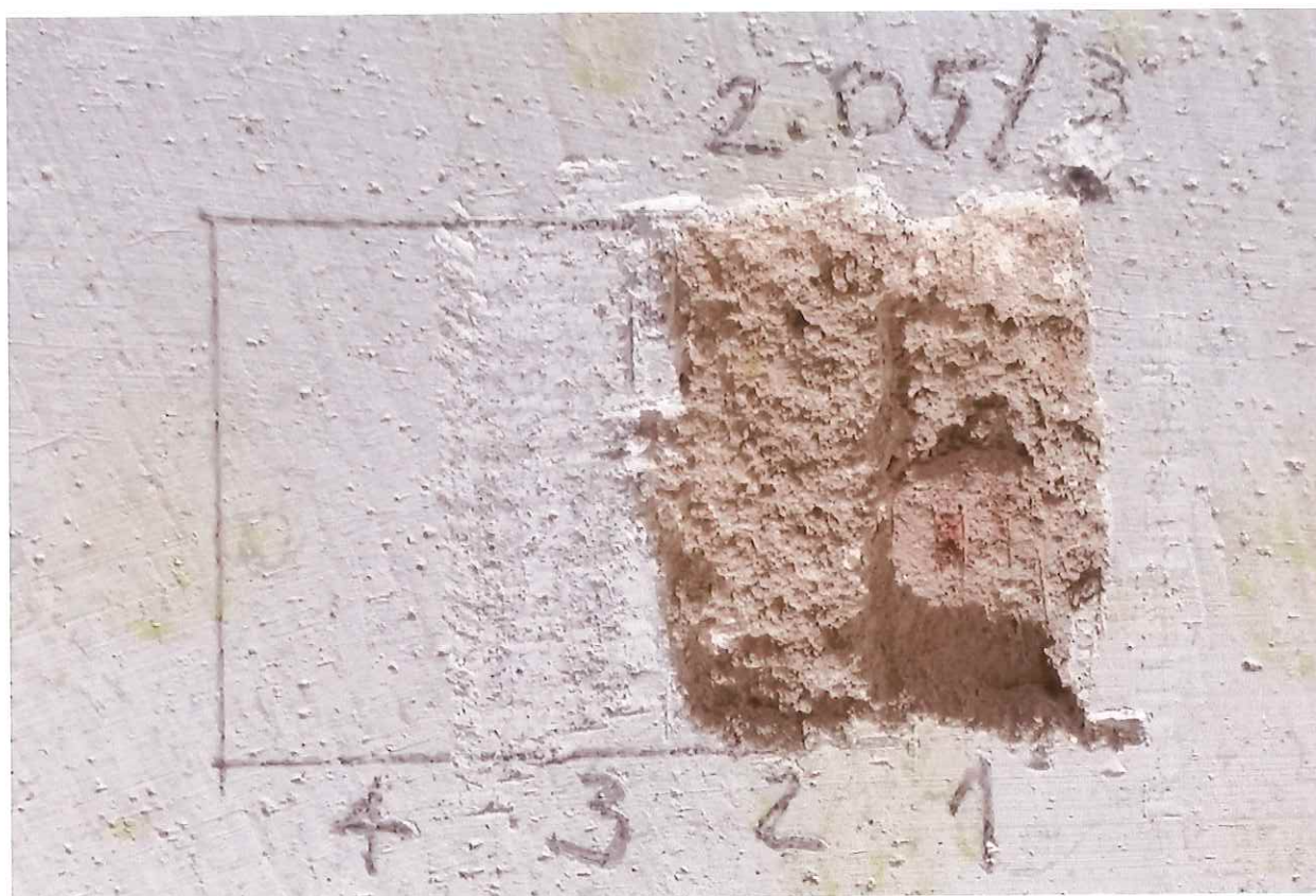
Sonda 2.05/3 na stěně – 1 cihlové zdivo, 2 jednovrstvá váp. omítka, 3 vrstva váp štuky, 4 monochromní hlínková výmalba
