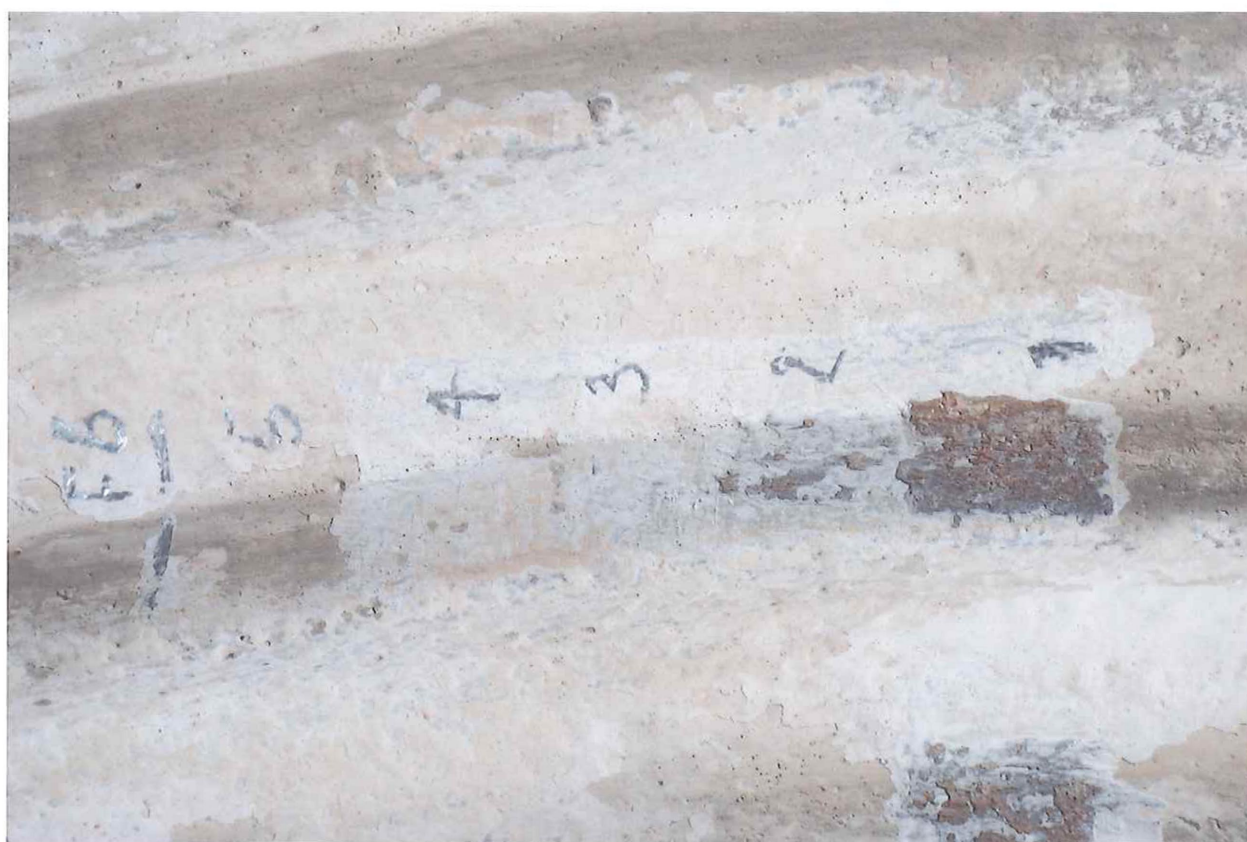
Sonda F6 na orámování vstupní brány – 1 kamenné ostění, 2-5 bílé nátěry
