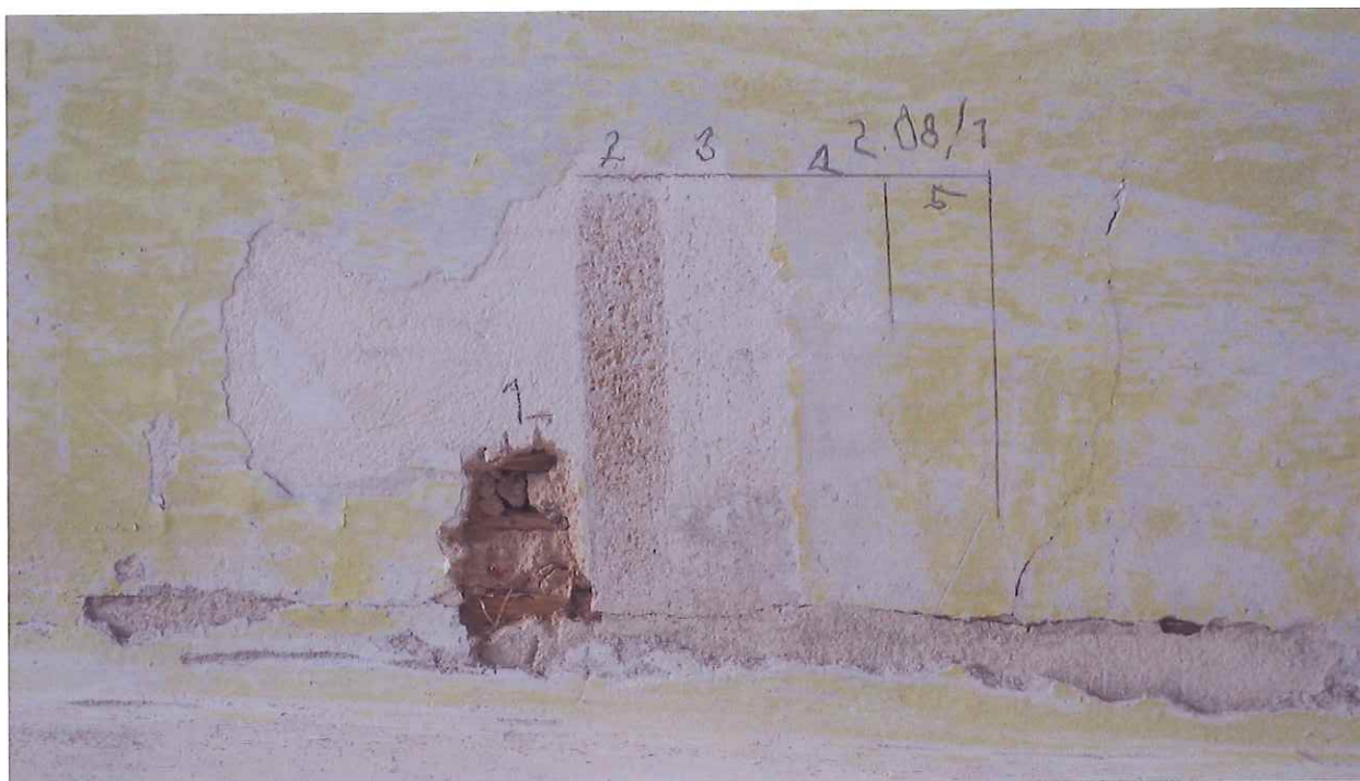
Sonda 2.08/1 na stropu – 1 rákosové pletivo, 2 váp. omítka žlutého zabarvení, 3 štuková vrstva, 4-5 monochromní hlinková vrstva
