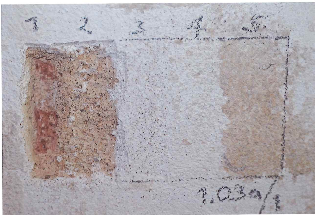
Sonda 1.03a/1 na stěně – 1 cihlové zdivo, 2 jednovrstvá váp. omítka, 3 štuková vrstva, 4-5 souvrství monochromních nátěrů
