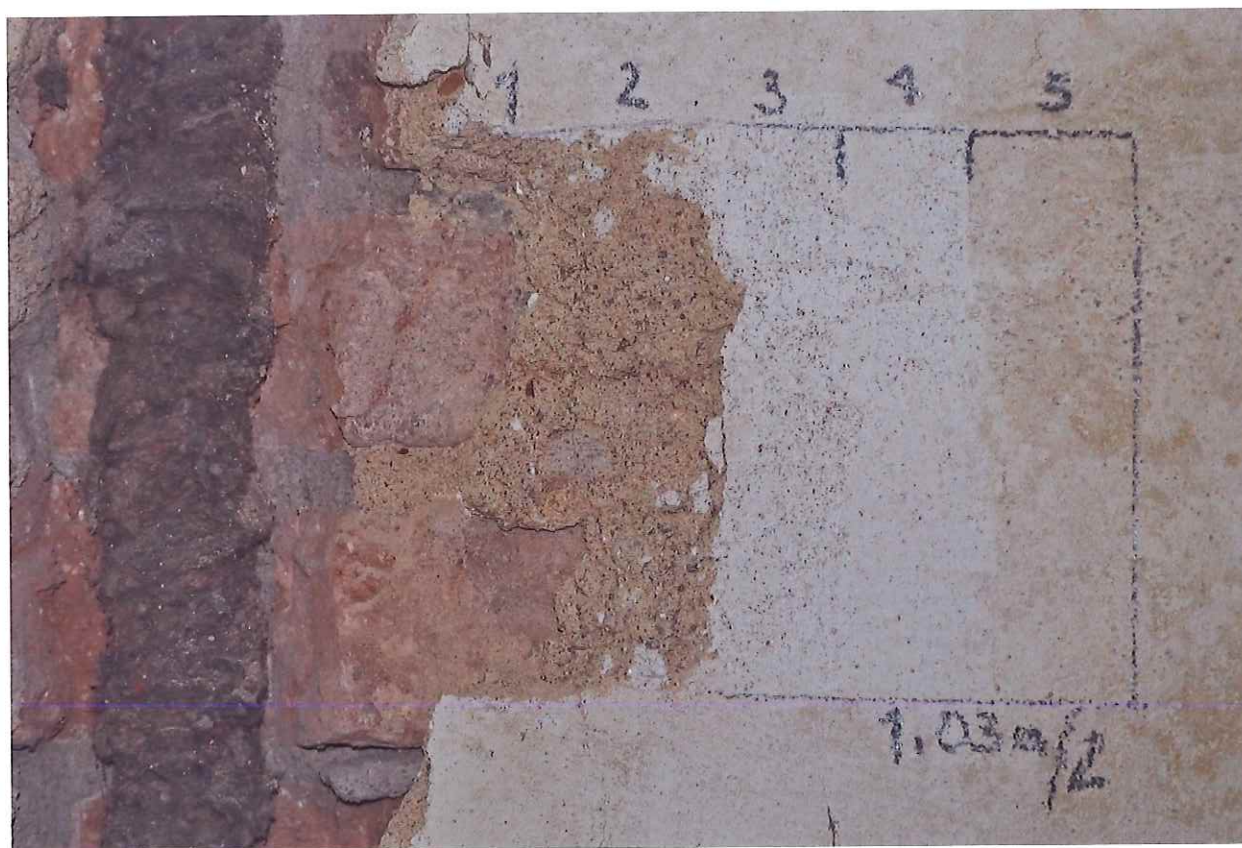
Sonda 1.03a/2 na stěně – 1 cihlové zdivo, 2 jednovrstvá váp. omítka, 3 štuková vrstva, 4-5 souvrství monochromních nátěrů
