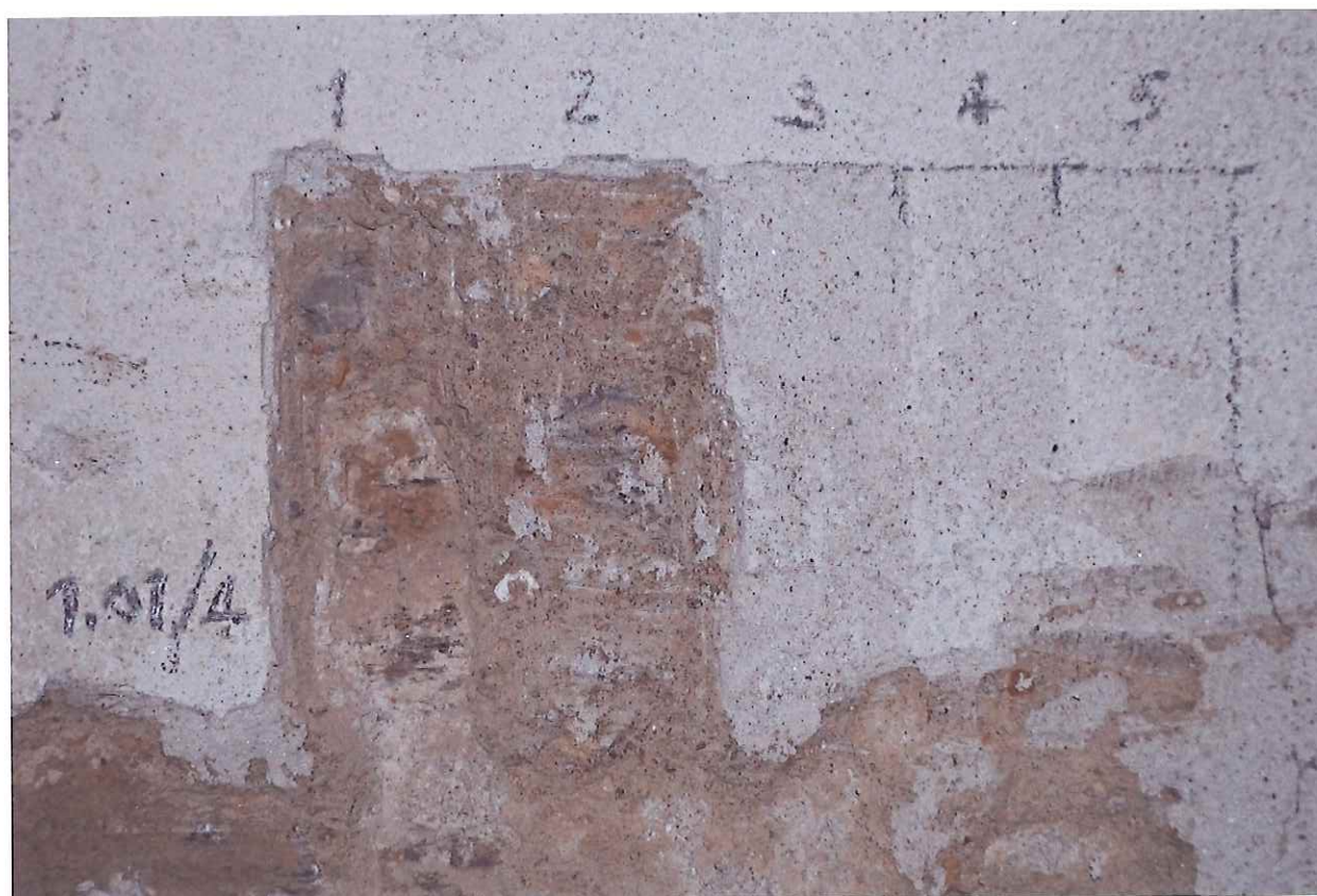
Sonda 1.01/4 na stěně - 1 kámen, 2 jednovrstvá váp. omítka, 3 štuková vrstva, 4-5 monochromní nátěry
