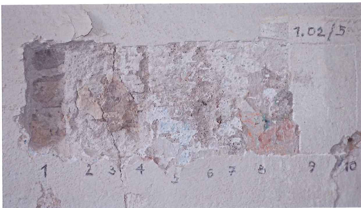
Sonda 1.02/5 na SZ stěně – 1 kamenné zdivo, 2 fragmenty nejstarší omítky s povrchovou úpravou, 3 mladší váp. omítka, 4-8 souvrství váp. omítky a nátěrů, 9 štuková vrstva, 10 monochromní hlínkový nátěr
