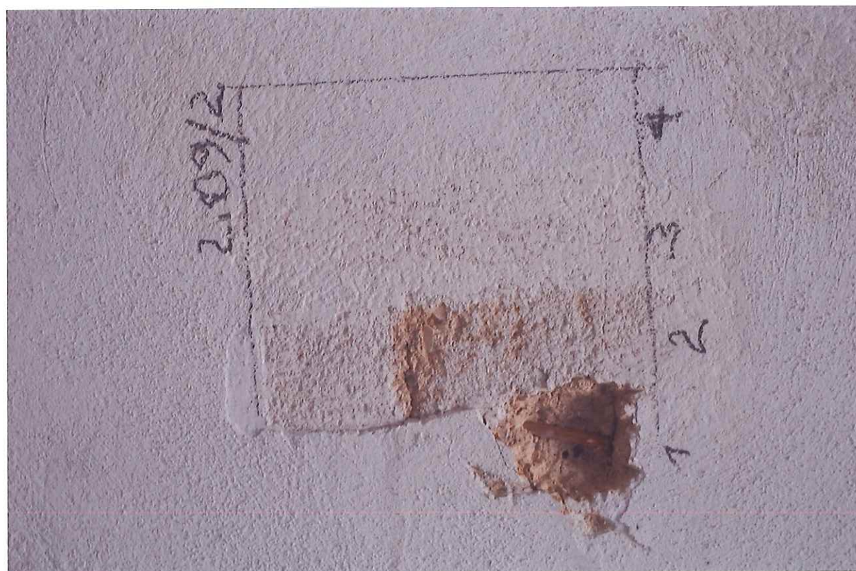
Sonda 2.09/2 na stropu – 1 rákosové pletivo a váp. omítka žlutého zabarvení, 2 štuková vrstva, 3-4 monochromní hlínková vrstva
