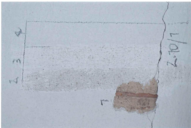
Sonda 2.10/1 na stropu – 1 rákosové pletivo a váp. omítka žlutého zabarvení, 2 štuková vrstva, 3-4 monochromní hlínková vrstva
