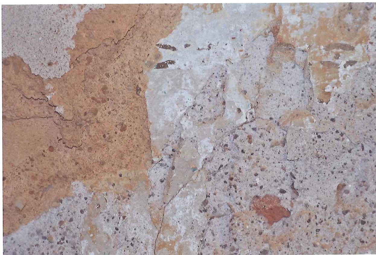
Detail předchozí sondy – rozhraní staré hrubozrnné vápenné omítky as omítkou novější žlutého zabarvení
