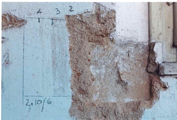
Sonda 2.10/6 na SV stěně – 1 kamenné zdivo, 2 jednovrstvá váp. omítka, 3 štuková vrstva, 4 souvrství monochromních nátěrů
