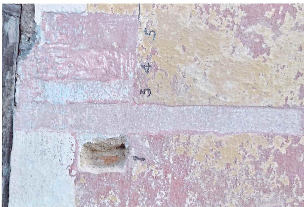
Sonda F1 na fasádě objektu – pásová sonda na monochromní vrstvě
