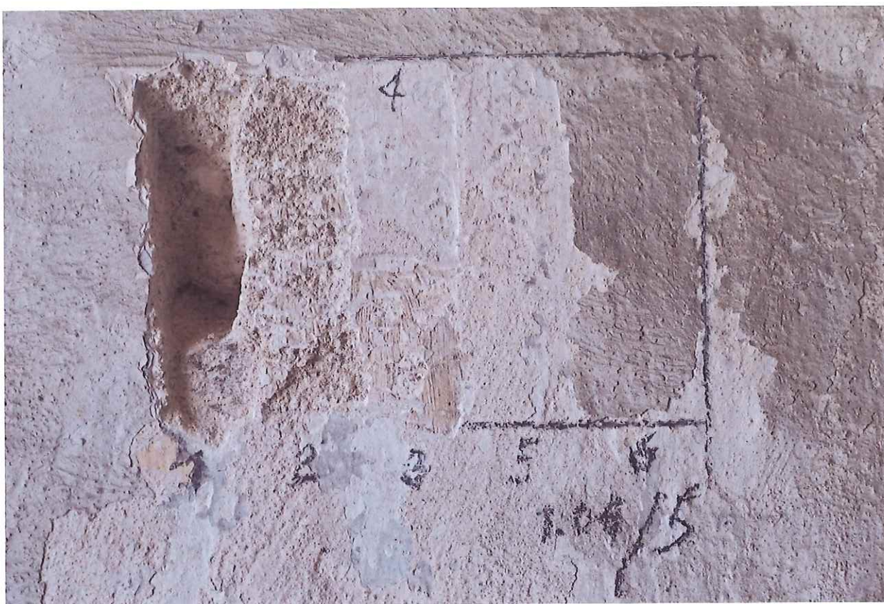
Sonda 1.04/5 na náběhu klenby – 1-2 kamenné zdivo s váp. omítkou, 3-6 souvrství monochromních váp. a hlínkových nátěrů
