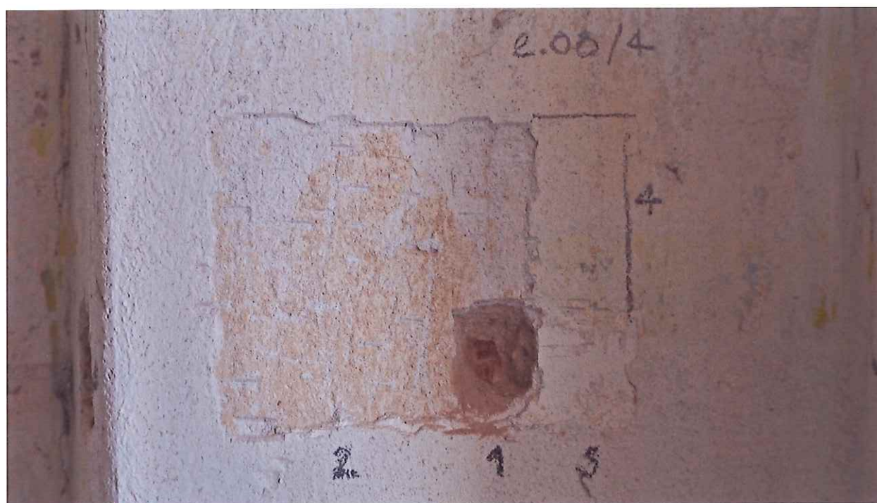
Sonda 2.08/4 na okenní špaletě – 1 cihlové zdivo, 2 jednovrstvá váp. omítka, 3 vrstva váp štuky, 4-5 monochromní hlínková výmalba doplněná válečkovým dekorem
