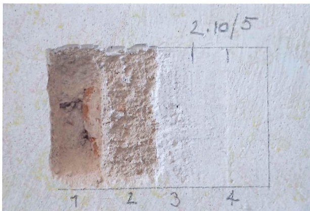
Sonda 2.10/5 na stěně – 1 cihlové zdivo, 2 jednovrstvá váp. omítka, 3 štuková vrstva, 4 souvrství malířských nátěrů monochromních
