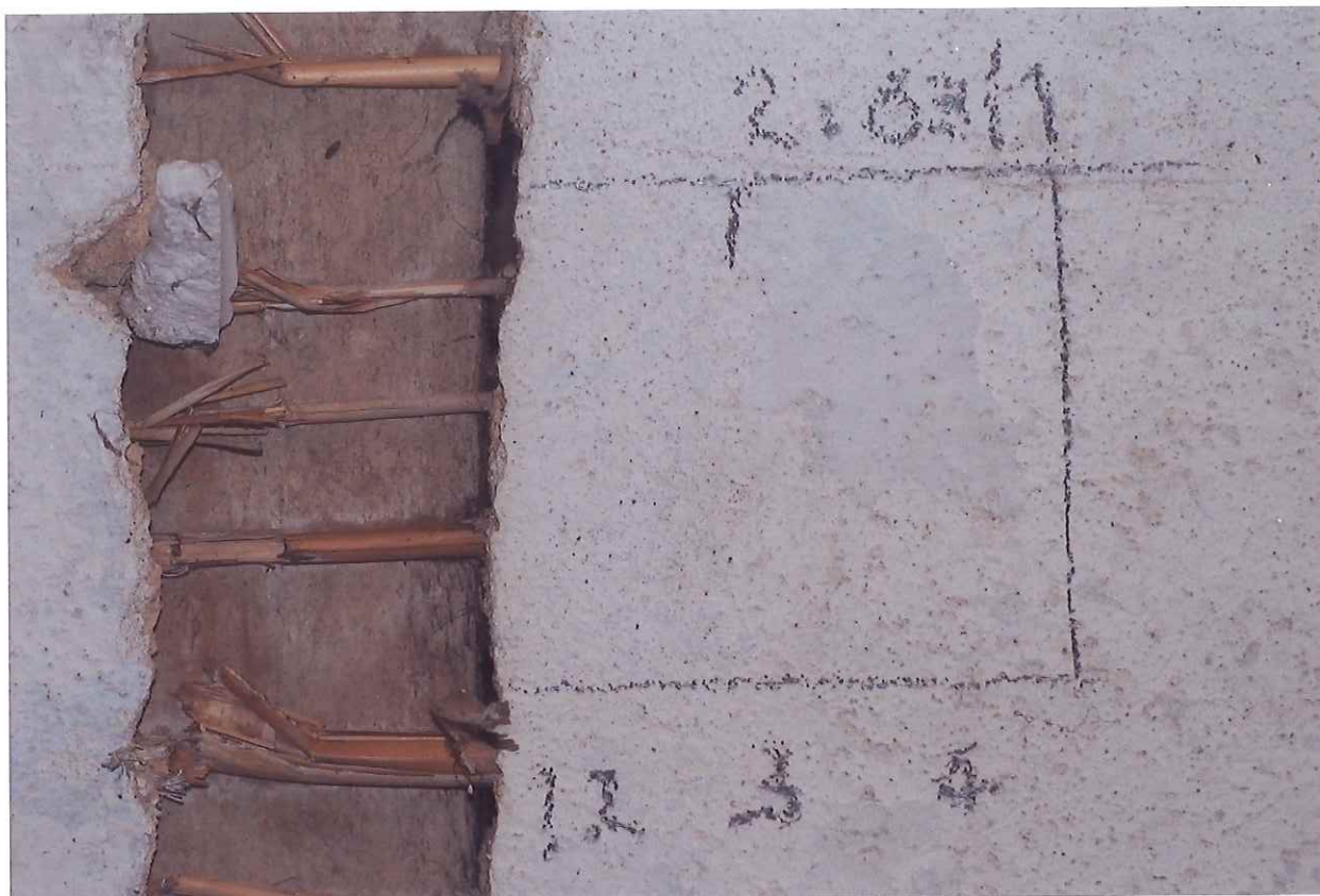
Sonda 2.03/1 na stropu – 1 rákosové pletivo, 2 váp. omítka žlutého zabarvení, 3 štuková vrstva, 4 monochromní hlínková vrstva
