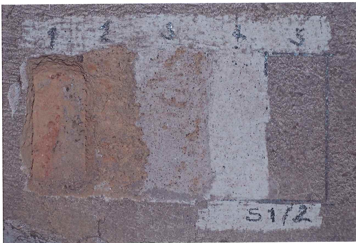
Sonda S1/2 na stěně – 1 cihlové zdivo, 2 jednovrstvá váp. omítka, 3 štuková vrstva, 4-5 monochromní hlínková výmalba
