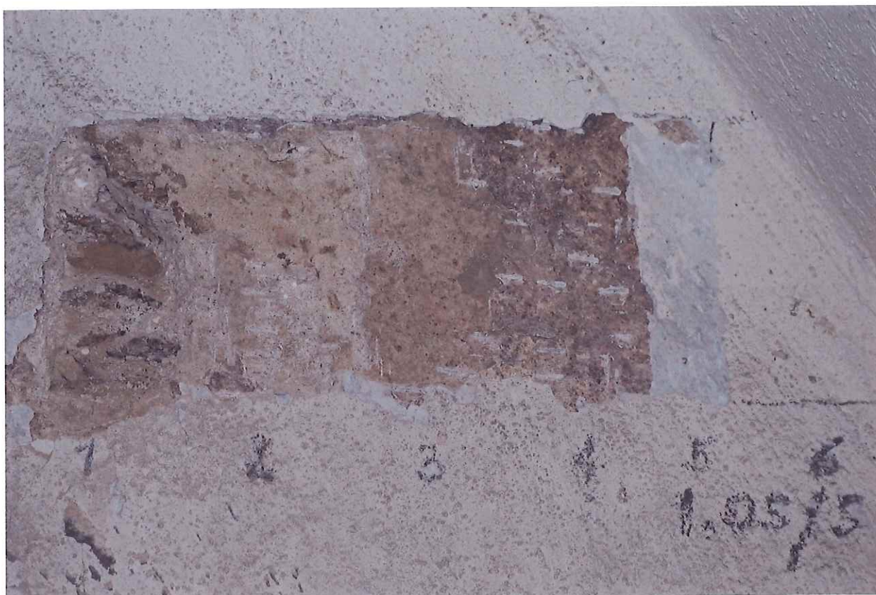
Sonda 1.05/5 na stěně – 1 cihlové zdivo, 2 jednovrstvá váp. omítka, 3 opravná omítka, 4 štuková vrstva, 5-6 souvrství monochromních nátěrů
