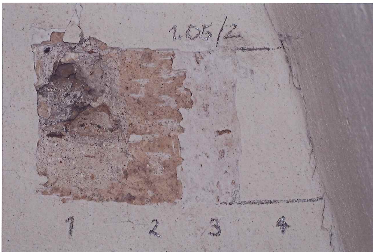
Sonda 1.05/2 na stěně – 1 cihlové zdivo, 2 jednovrstvá váp. omítka, 3 štuková vrstva, 4 souvrství monochromních nátěrů
