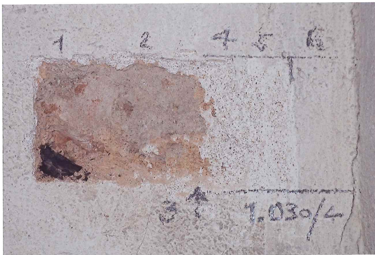
Sonda 1.03a/4 na stěně – 1 cihlové zdivo, 2 jednovrstvá váp. omítka, 3 opravná mladší omítka, 4 štuková vrstva, 5-6 souvrství monochromních nátěrů
