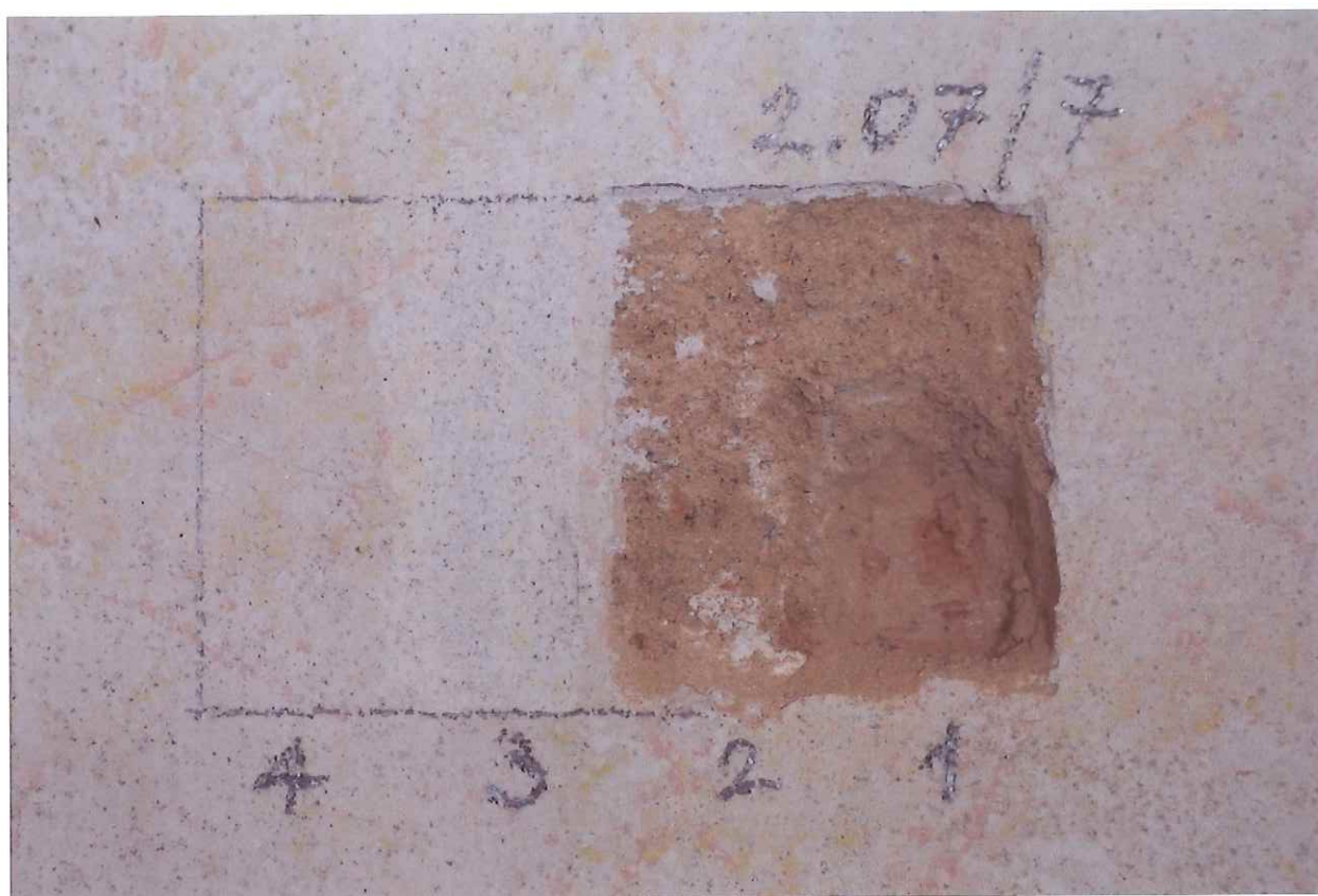
Sonda 2.07/7 na stěně – 1 cihlové zdivo, 2 jednovrstvá váp. omítka, 3 vrstva váp štku, 4 monochromní hlinková výmalba doplněná válečkovým dekorem
