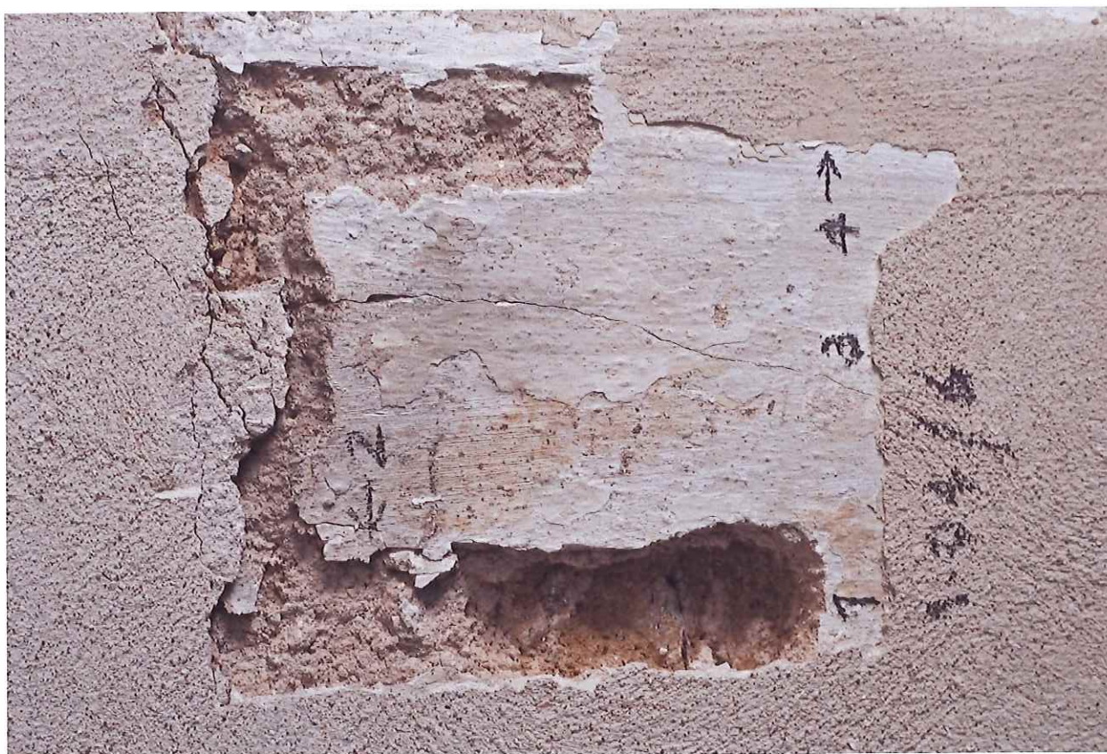
Sonda 1.04/6 na stěně – 1-2 kamenné zdivo s váp. omítkou, 3-4 souvrství monochromních váp. a hlínkových nátěrů
