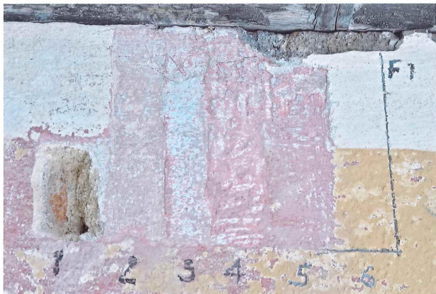
Sonda F1 na fasádě objektu – 1 cihlové zdivo, jednovrstvá váp. omítka a štuková vrstva, 2 nejstarší dochovaná barevná úprava fasády bez bílých okenních orámování, 3-5 souvrství vápenných nátěrů, 6 nejmladší barevná úprava
