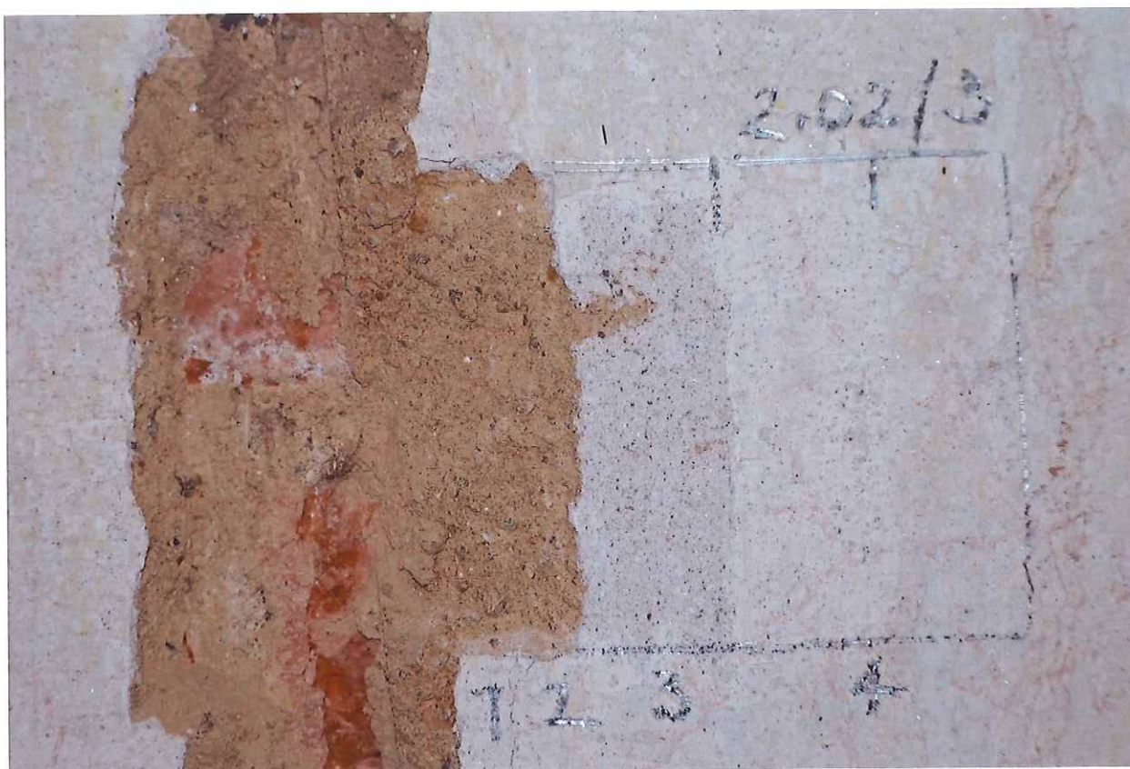
Sonda 2.02/3 na stěně – 1-2 cihlové zdivo a jednovrstvá váp. omítka, 3 vrstva váp štuku, 4 monochromní hlínková výmalba
