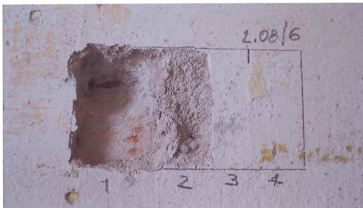
Sonda 2.08/6 na stěně – 1 cihlové zdivo, 2 jednovrstvá váp. omítka, 3 vrstva váp štuky, 4 monochromní hlínková výmalba doplněná válečkovým dekorem
