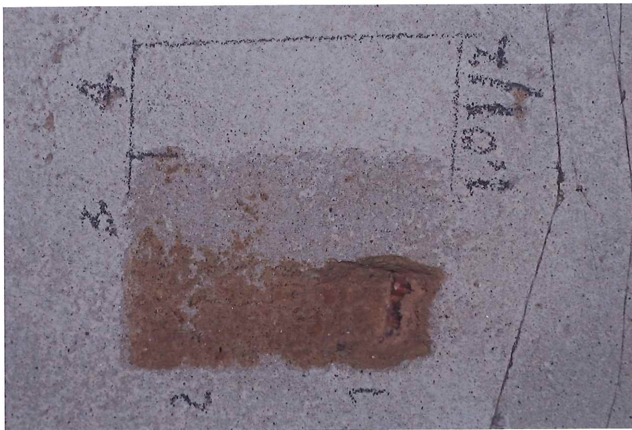
Sonda 1.01/2 na klenbě – 1 cihelné zdivo, 2 jednovrstvá váp. omítka, 3 souvrství váp. nátěrů, 4 současná hlinka
