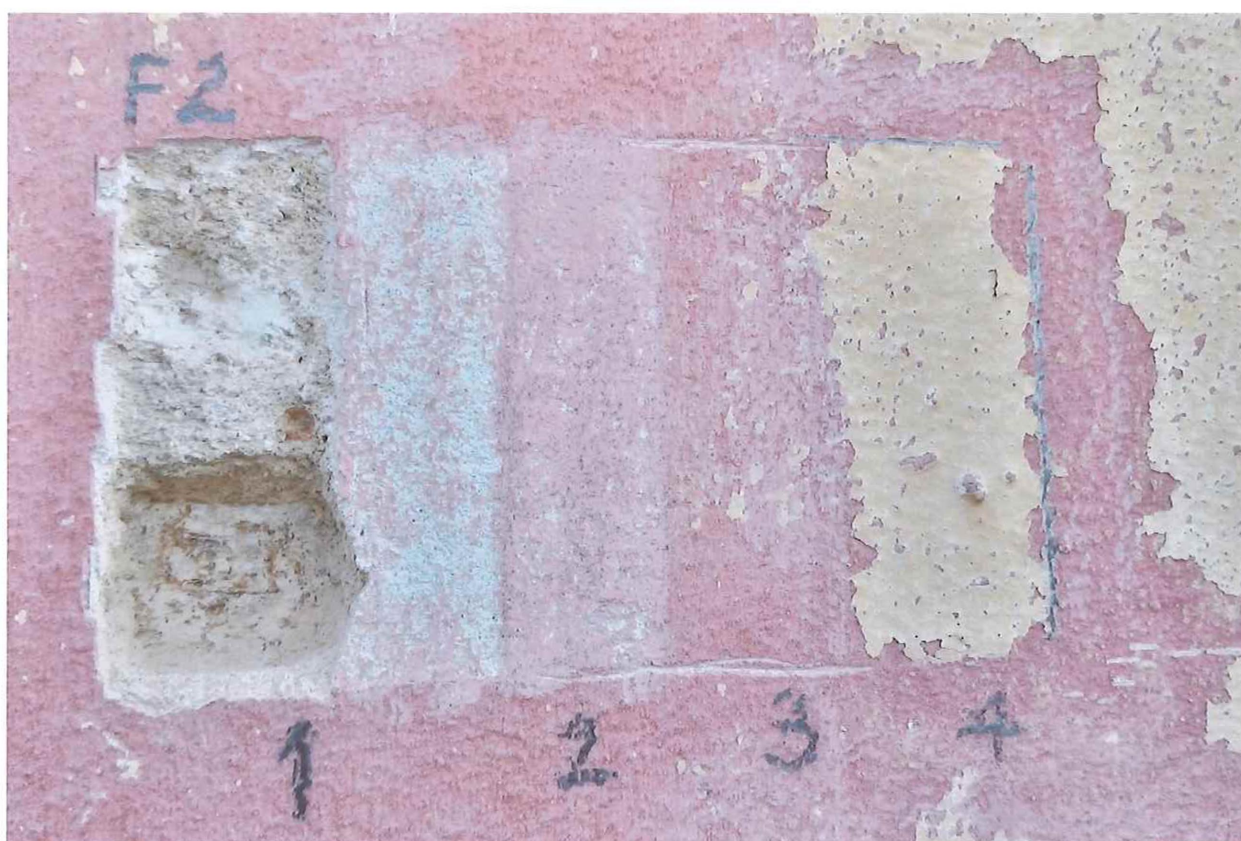
Sonda F2 na fasádě objektu – 1 cihlové zdivo a jednovrstvá váp. omítka, 2-4 povrchové úpravy fasády
