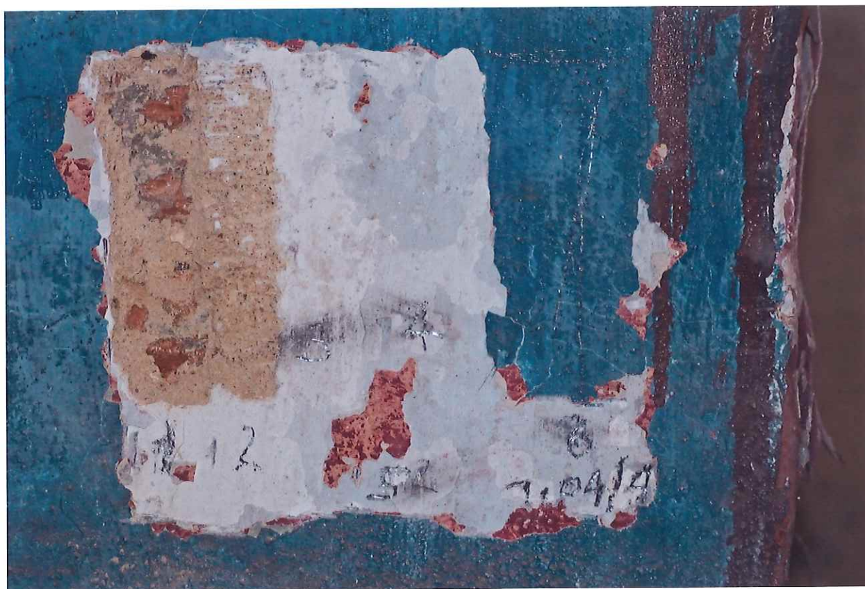
Sonda 1.04/4 na stěně výklenku – 1-2 cihlové zdivo s váp. omítkou, 3-6 souvrství monochromních váp. a hlinkových nátěrů
