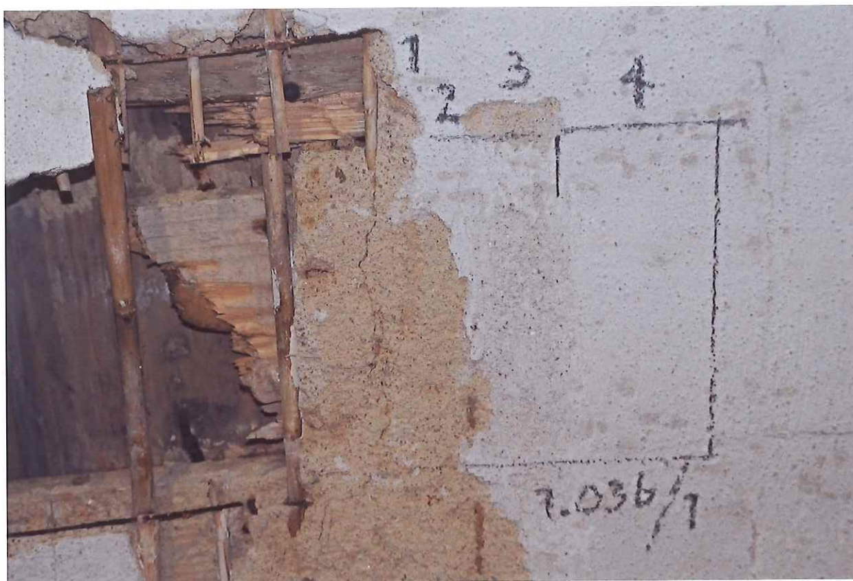
Sonda 1.03b/1 na stropu – 1 rákosové pletivo, 2 jednovrstvá váp. omítka, 3 štuková vrstva, 4 monochromní váp. nátěr
