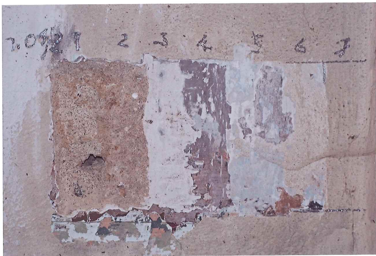
Sonda 1.04/2 na stěně – 1-2 cihlové zdivo s váp. omítkou, 3-7 souvrství monochromních váp. a hlinkových nátěrů
