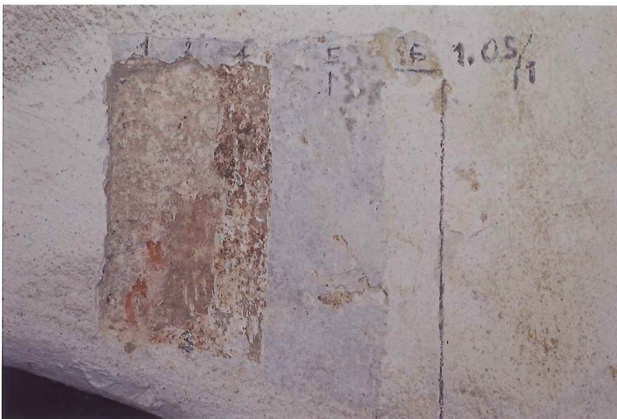
Sonda 1.05/1 na stěně – 1 cihlové zdivo, 2 jednovrstvá váp. omítka, 3 opravná omítka, 4 štuková vrstva, 5 souvrství monochromních nátěrů
