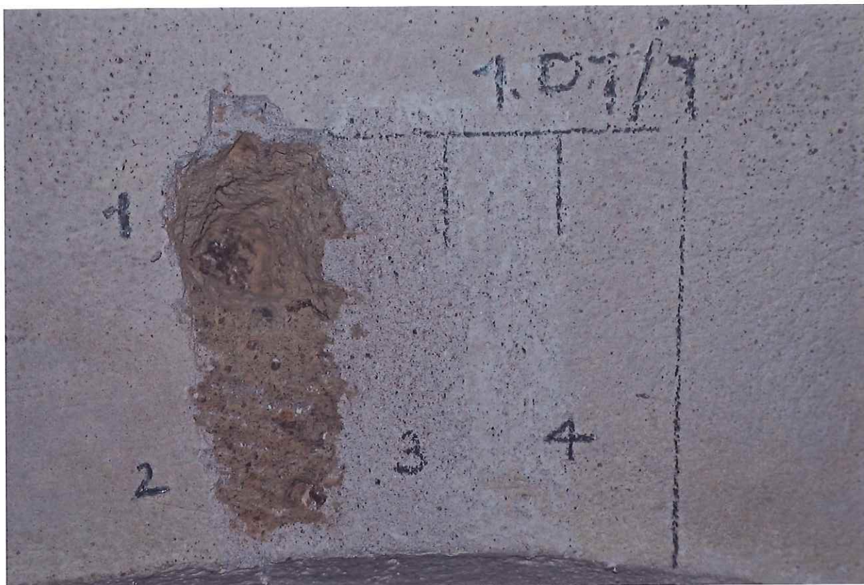
Sonda 1.01/1 na klenbě – 1 cihelné zdivo, 2 jednovrstvá váp. omítka, 3 souvrství váp. nátěrů, 4 současná hlinka
