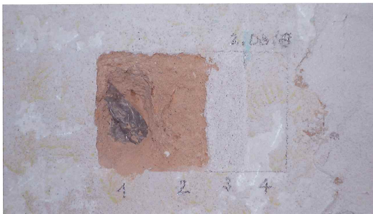
Sonda 2.08/8 na stěně – 1 cihlové zdivo, 2 jednovrstvá váp. omítka, 3 vrstva váp štuky, 4 monochromní hlínková výmalba doplněná válečkovým dekorem
