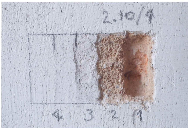
Sonda 2.10/4 na stěně – 1 cihlové zdivo, 2 jednovrstvá váp. omítka, 3 štuková vrstva, 4 souvrství hlínkových maleb
