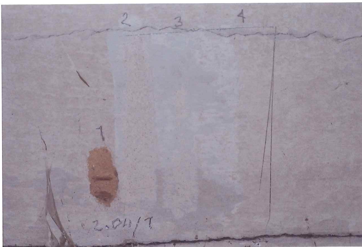
Sonda 2.04/1 na stropu – 1 rákosové pletivo a váp. omítka žlutého zabarvení, 2 štuková vrstva, 3-4 monochromní hlínková vrstva
