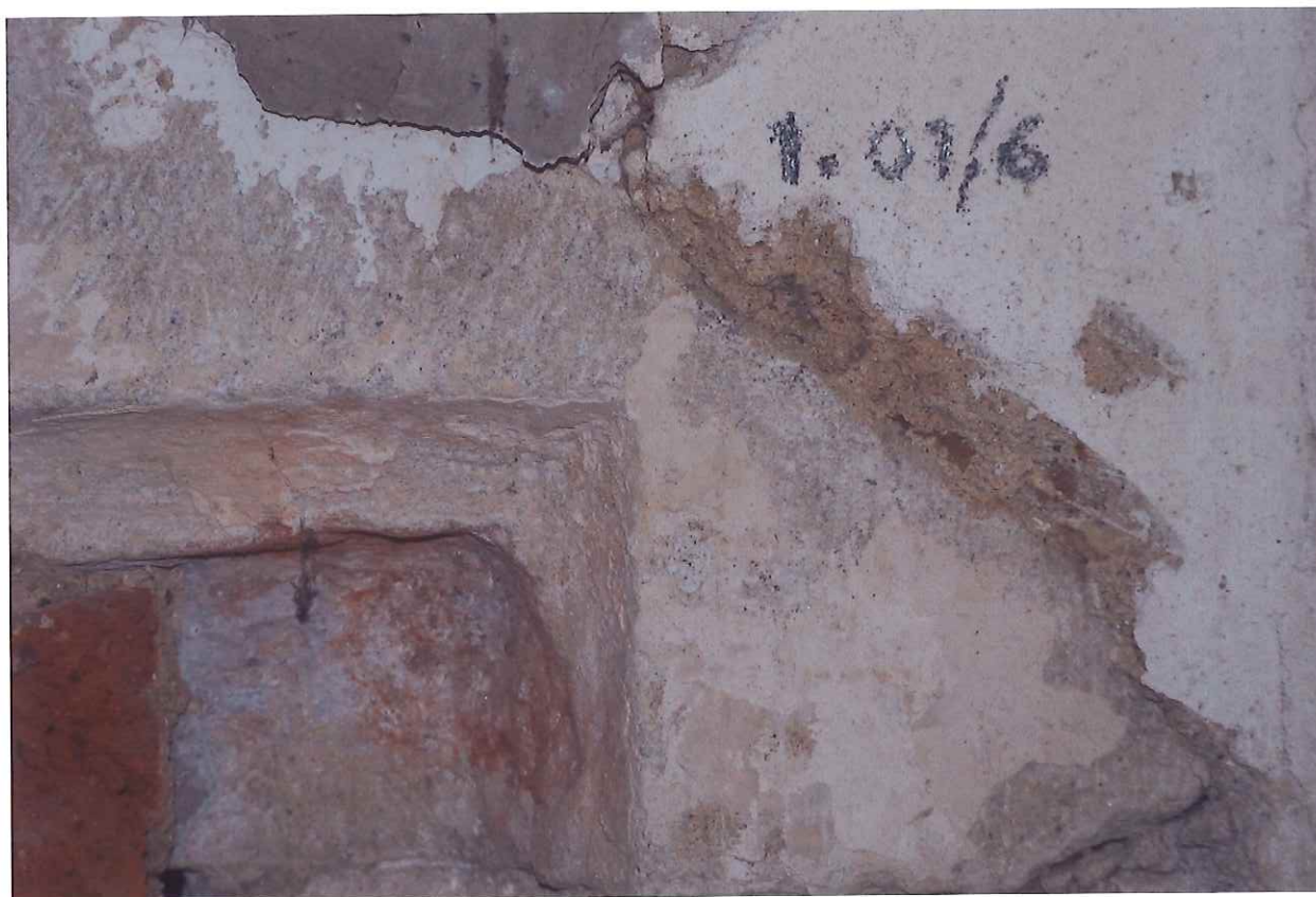
Sonda 1.01/6 – ukázka vrstvení a nátěrů na kamenném dveřním ostění
