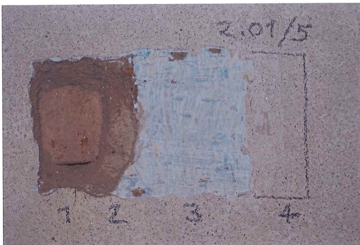
Sonda 2.01/5 na stěně – 1 cihlové zdivo, 2 jednovrstvá váp. omítka, 3 štuková vrstva s váp. výmalbou, 4 souvrství monochromních nátěrů
