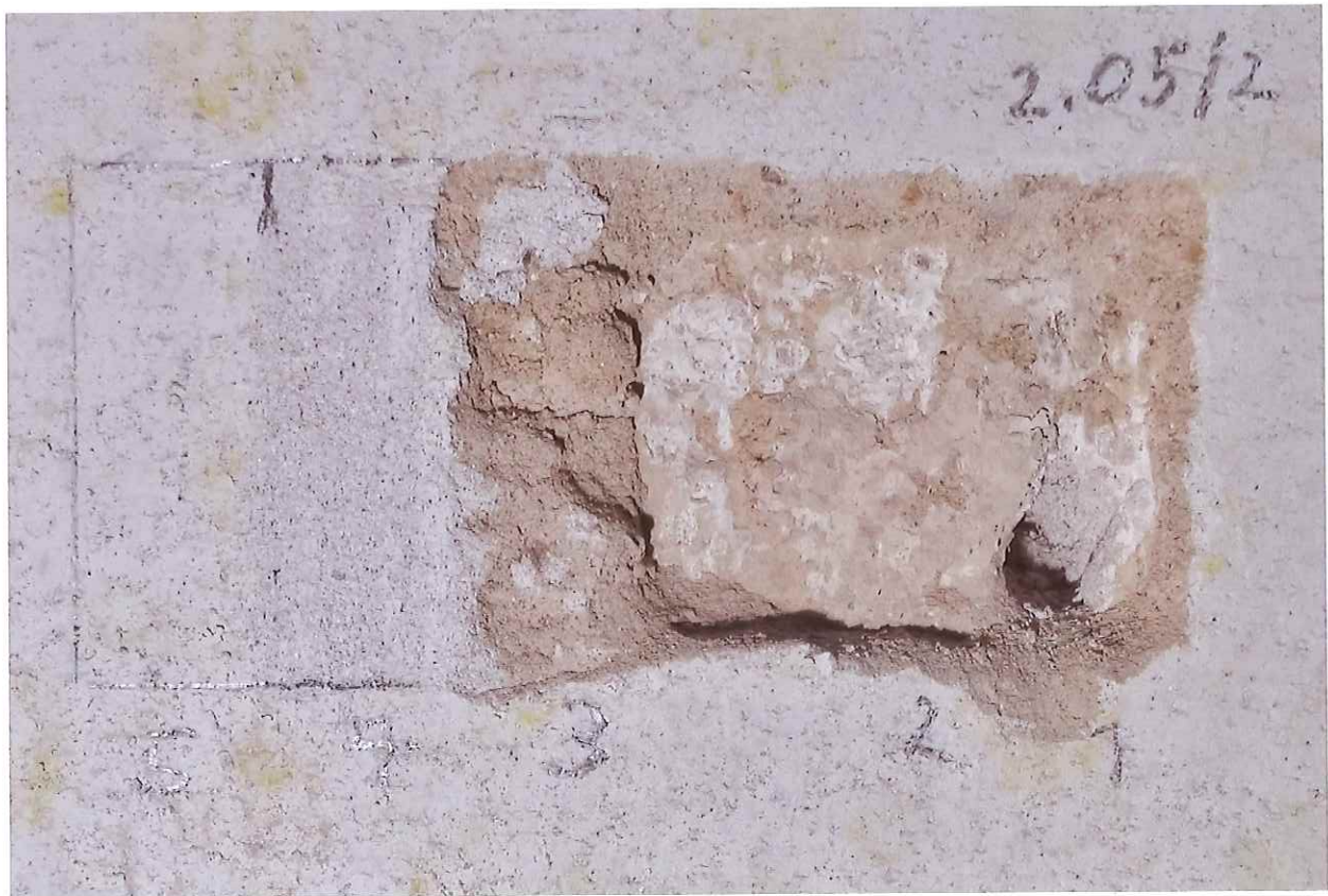
Sonda 2.05/2 na stěně – 1 cihlové zdivo, 2 jednovrstvá váp. omítka, 3 vrstva opravné váp. omítky, 4-5 souvrství váp. štku a monochromní hlínková výmalba
