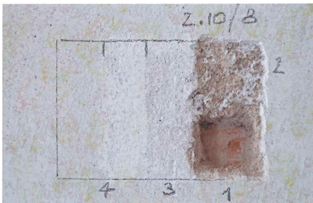
Sonda 2.10/8 na stěně – 1 cihlové zdivo, 2 jednovrstvá váp. omítka, 3 štuková vrstva, 4 souvrství hlinkových nátěrů
