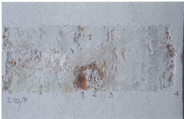
Sonda 2.10/7 na náběhu oblouku arkýře – 1 cihlové zdivo, 2 jednovrstvá váp. omítka, 3 malířská vrstva na bílém váp. podkladu, 4 souvrství váp. štuků a monochromních nátěrů
