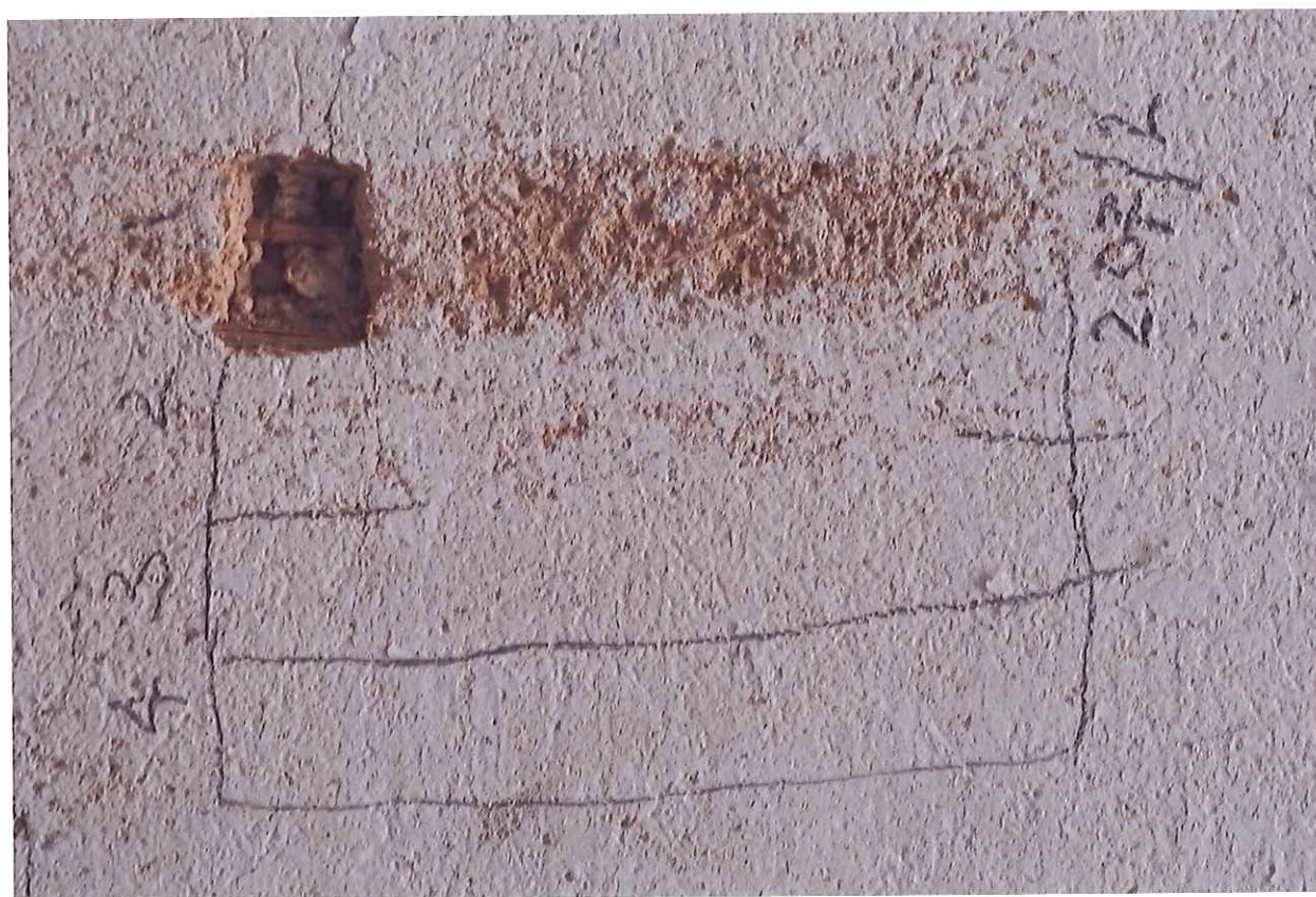
Sonda 2.07/2 na stropu – 1 rákosové pletivo a váp. omítka žlutého zabarvení, 2 štuková vrstva, 3-4 monochromní hlínková vrstva
