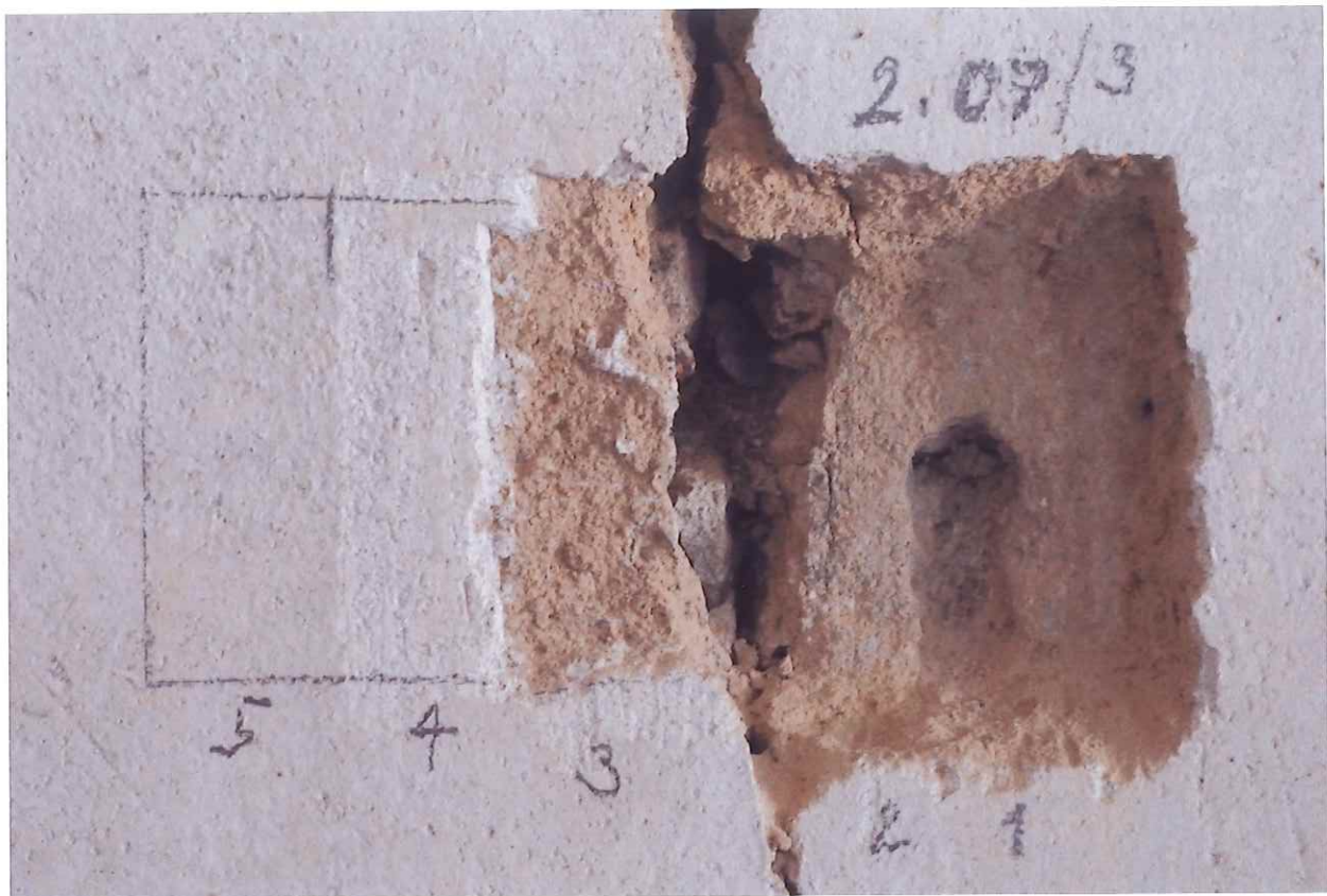
Sonda 2.07/3 na stěně – 1 kamenné zdivo, 2 jednovrstvá váp. omítka, 3 vápenná vrstva, 4 vrstva váp štuku, 5 monochromní hlínková výmalba
