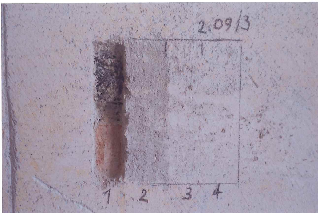
Sonda 2.09/3 na stěně – 1-2 cihlové zdivo a jednovrstvá váp. omítka, 3-4 souvrství hlínkových nátěrů
