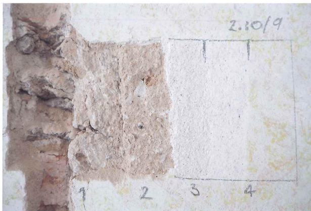
Sonda 2.10/9 na stěně – 1 cihlové zdivo, 2 jednovrstvá váp. omítka, 3 štuková vrstva, 4 souvrství monochromních nátěrů
