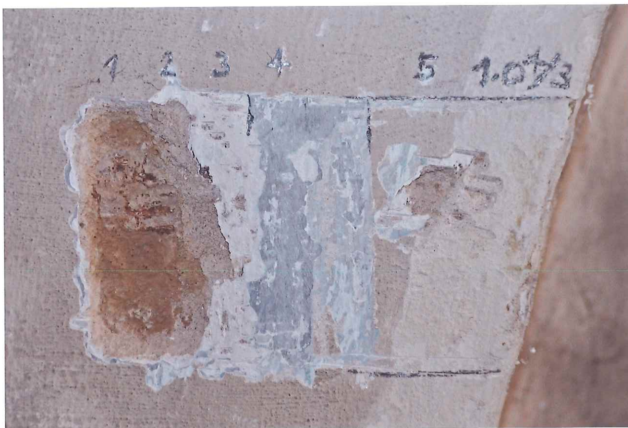
Sonda 1.04/3 na náběhu klenby – 1-2 cihlové zdivo s váp. omítkou, 3-5 souvrství monochromních váp. a hlinkových nátěrů
